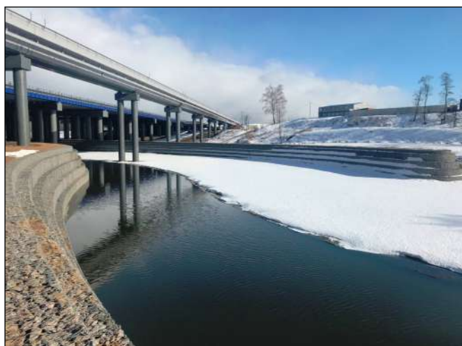
Армогрунтовая система Террамеш вдоль русла Клязьмы
