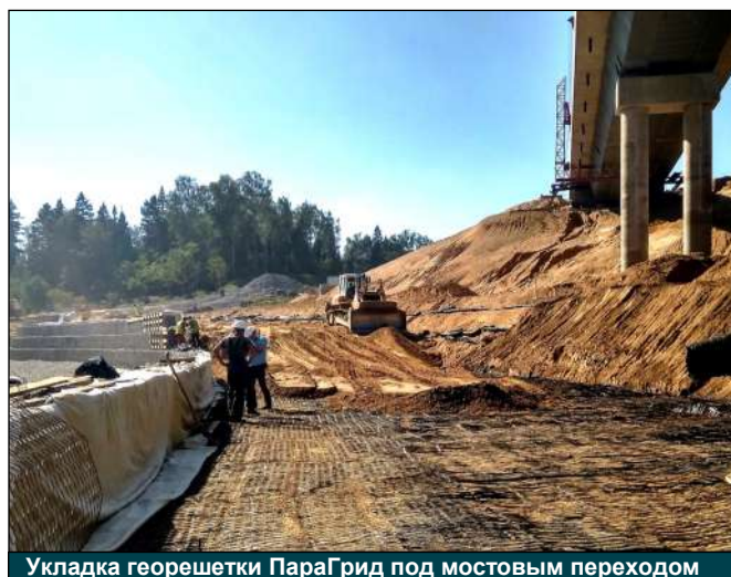
Укладка георешетки ПараГрид под мостовым переходом
