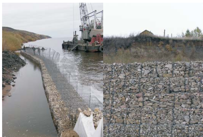
В процессе строительства
