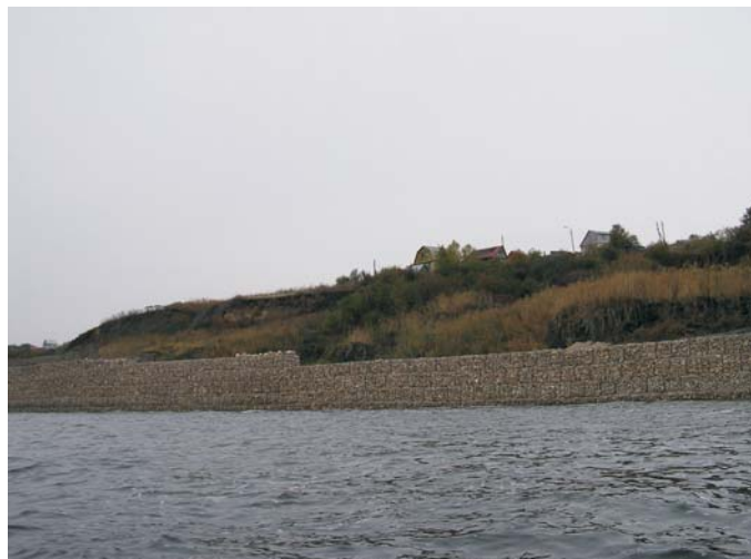
В процессе строительства
