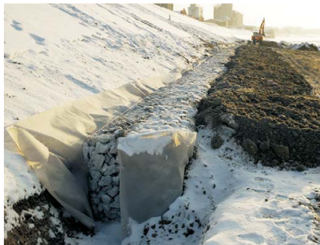
Начало работ, декабрь 2005
