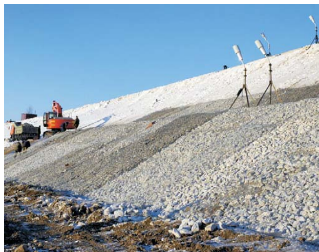
В процессе строительства, февраль 2006
