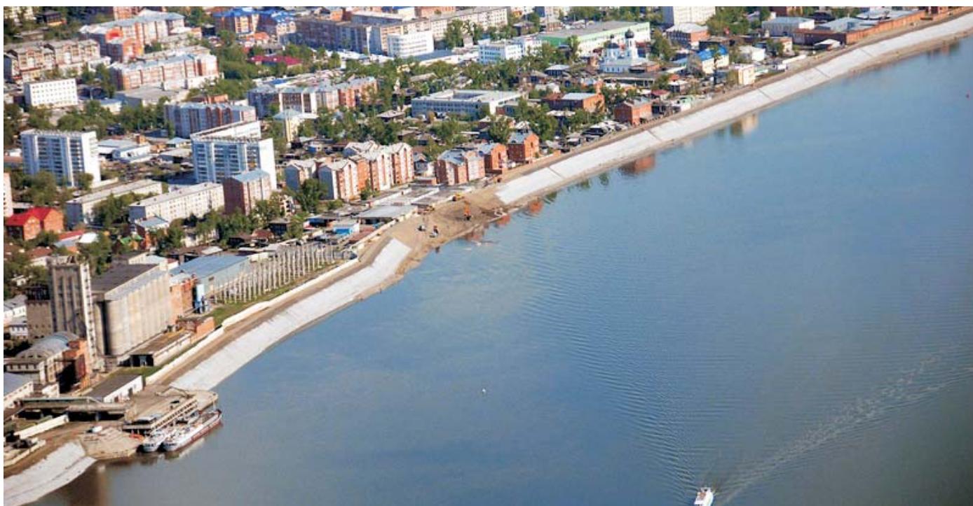
В процессе строительства, апрель 2008
