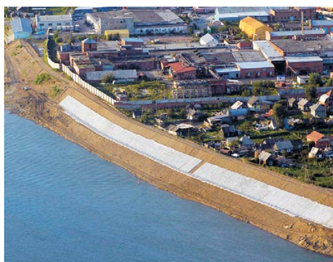
В процессе строительства, август 2006
