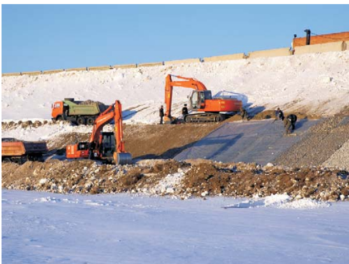
В процессе строительства, февраль 2006
