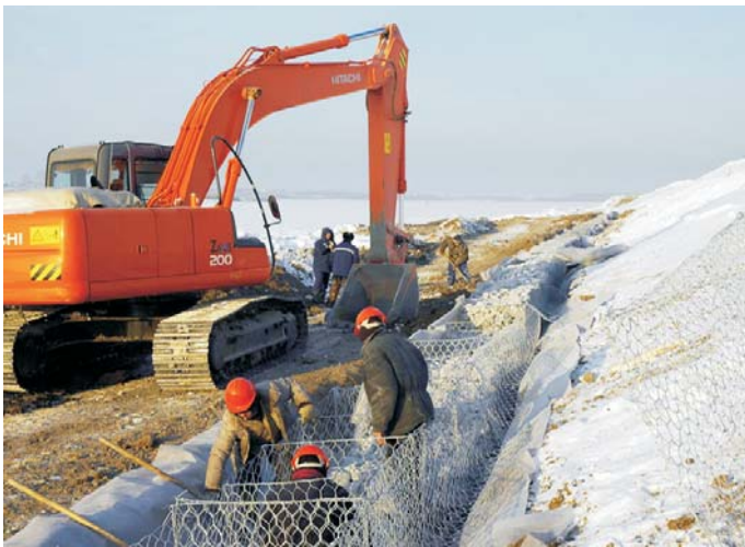
Начало работ, декабрь 2005
