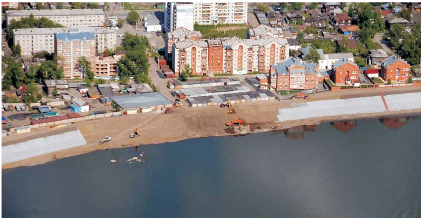
В процессе строительства, апрель 2008
