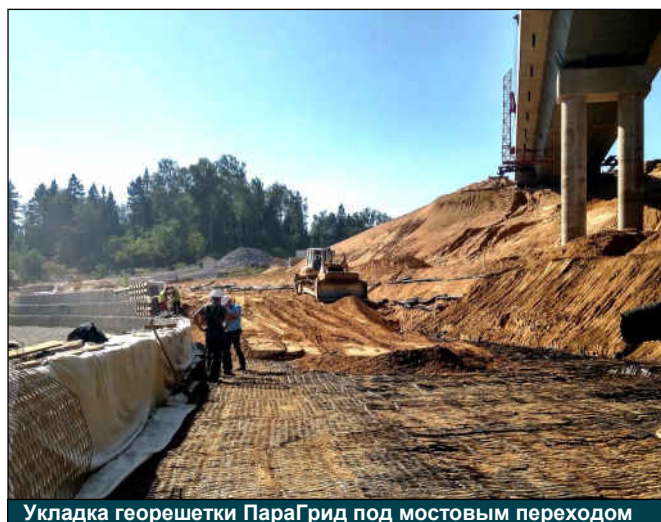
Укладка георешетки ПараГрид под мостовым переходом
