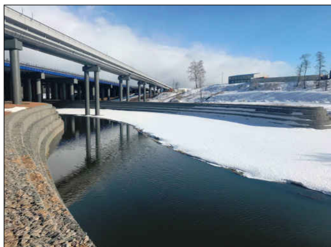
Армогрунтовая система Террамеш вдоль русла Клязьмы
