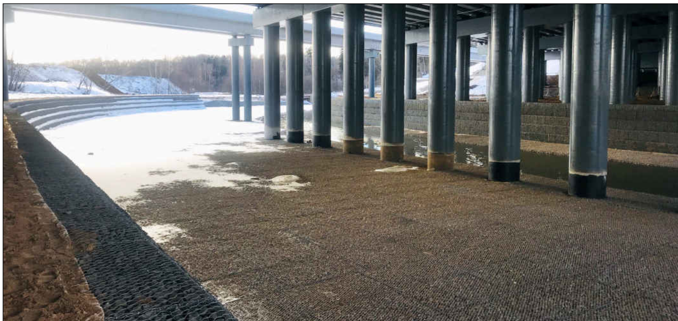
Противоэрозионная защита подмостового пространства и русла реки Клязьма
