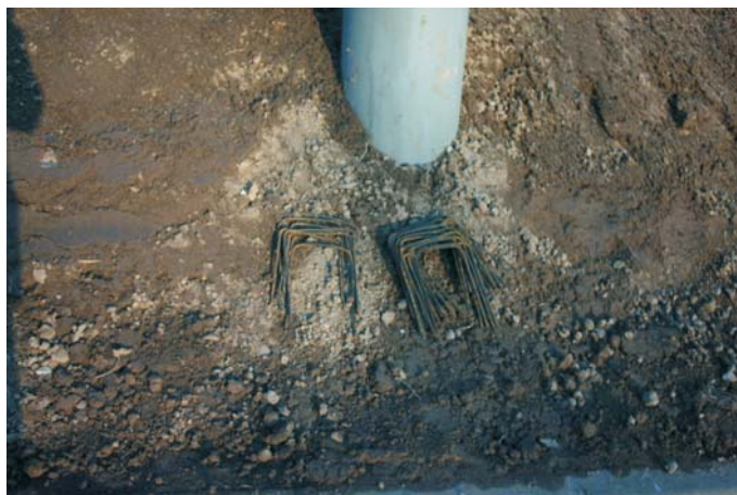
В процессе строительства - анкера
