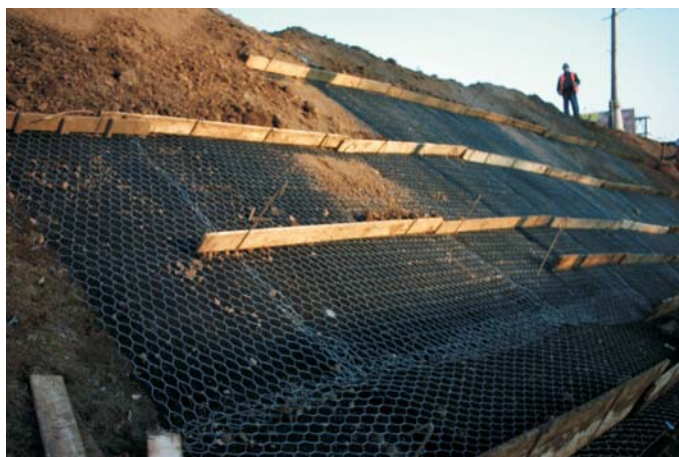
В процессе строительства
