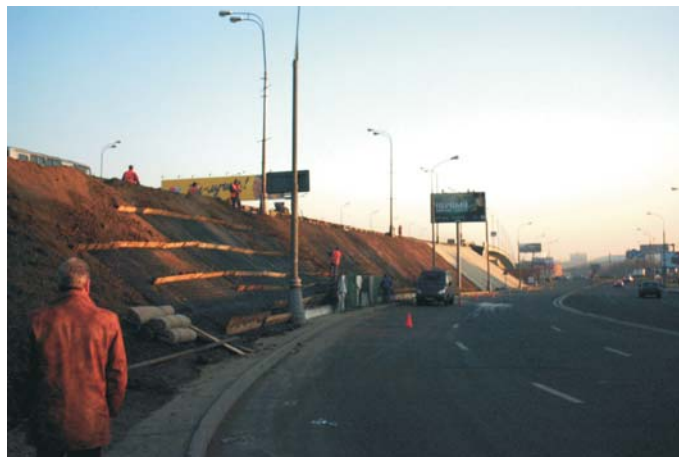
В процессе строительства
