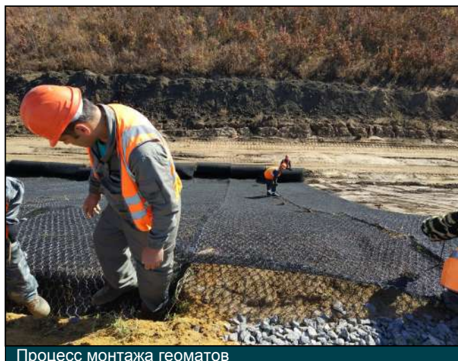
Процесс монтажа геоматов
