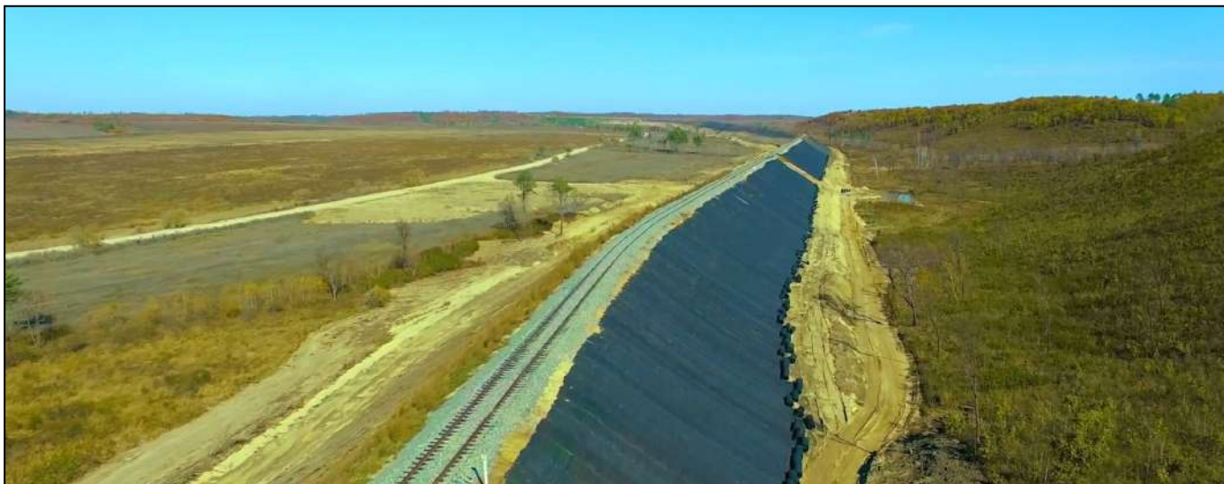
Укладка геоматов МакМат R 6822 GO на железнодорожные откосы
