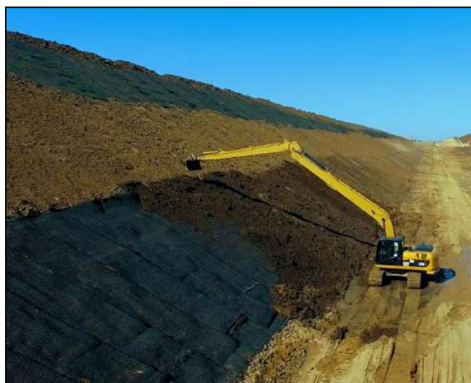
Засыпка геоматов растительным грунтом
