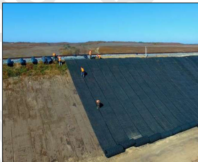
Установка и раскатка рулонов на склоне
