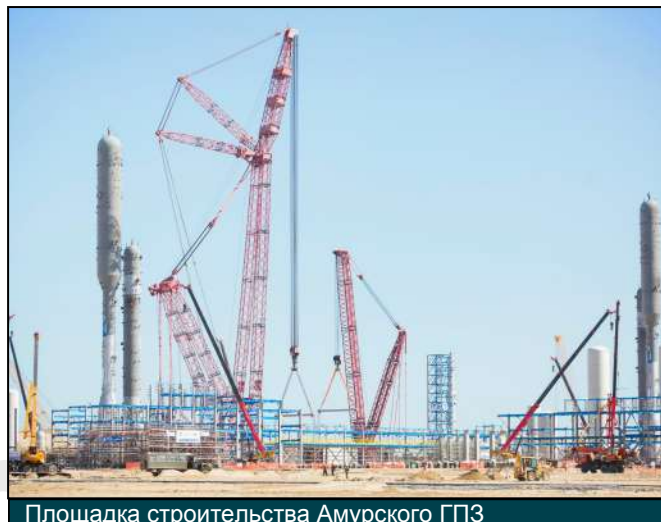
Площадка строительства Амурского ГПЗ
