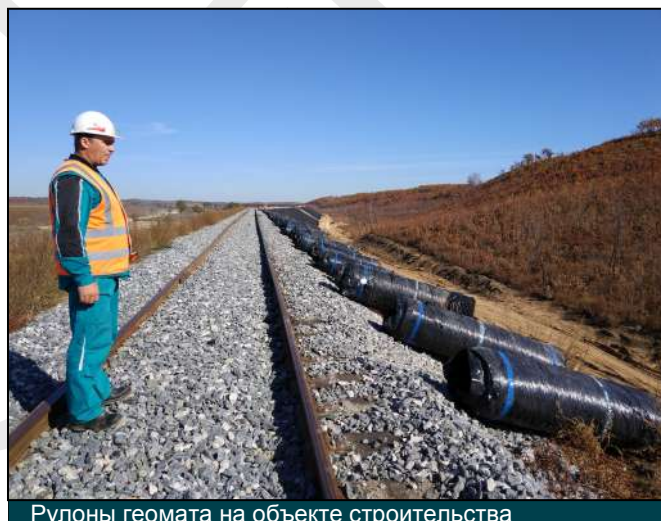
Рулоны геомата на объекте строительства
