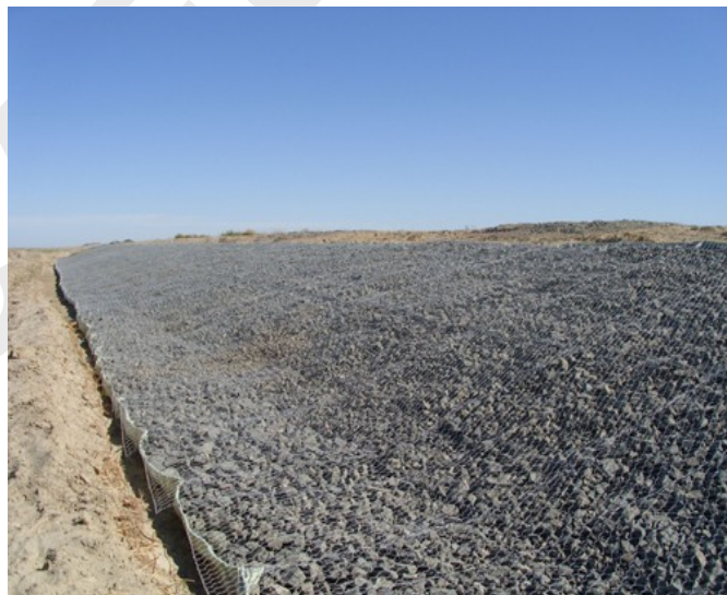
По окончании строительства
