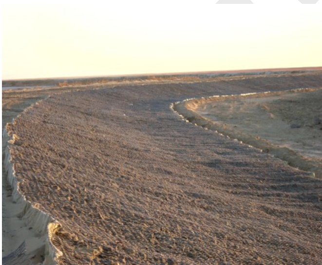
По окончании строительства
