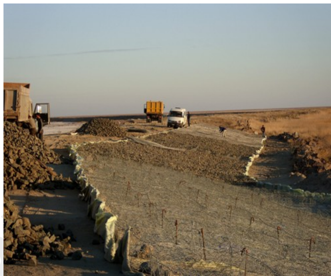
В процессе строительства
