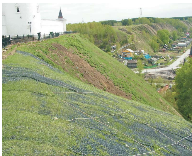
Рис. 7 По завершении строительства
