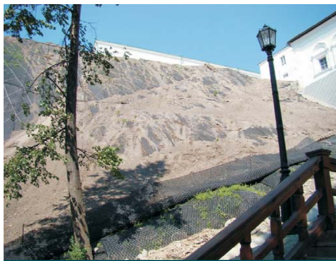
Рис. 5 В процессе строительства
