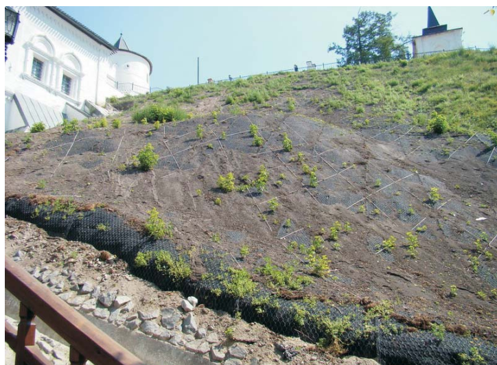
Рис. 6 По завершении строительства
