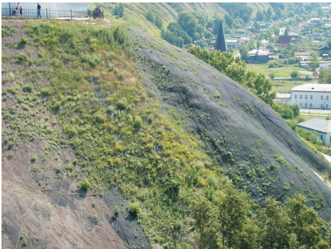
Рис. 8 По окончании строительства
