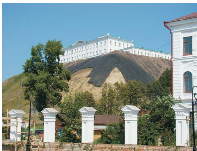
Рис. 4 В процессе строительства
