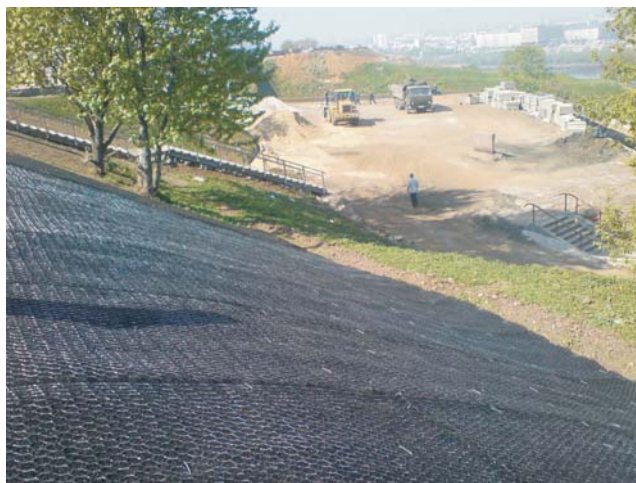
Рис. 4 В процессе строительства
