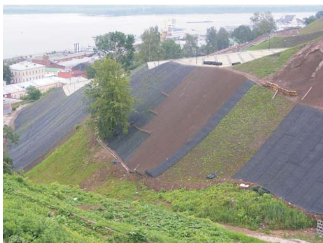
Рис. 5 В процессе строительства
