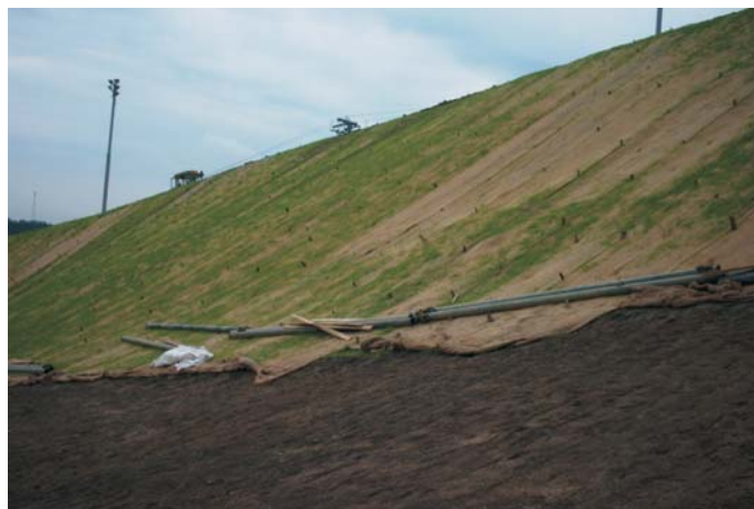
В процессе строительства
