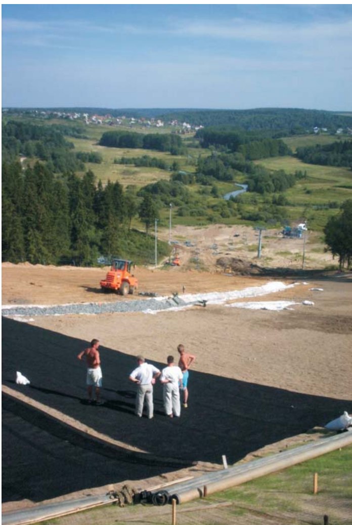
В процессе строительства
