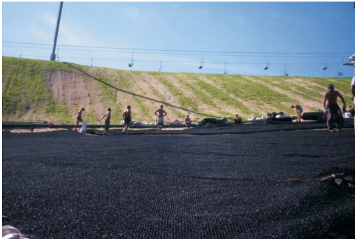
В процессе строительства
