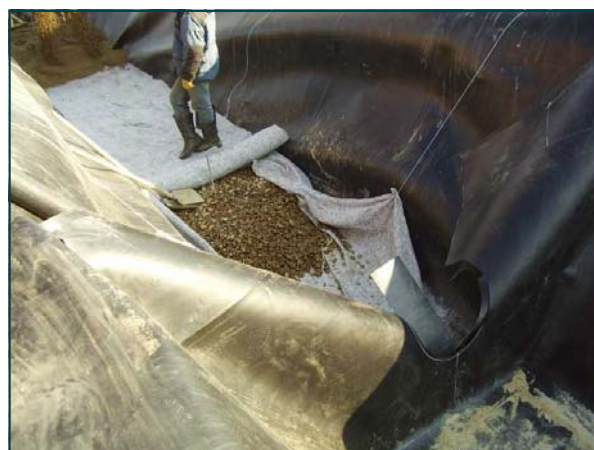
Водонепроницаемая траншея. Внутренний дренаж
