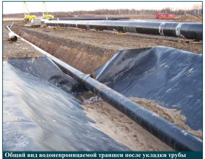
Общий вид водонепроницаемой траншеи после укладки трубы
