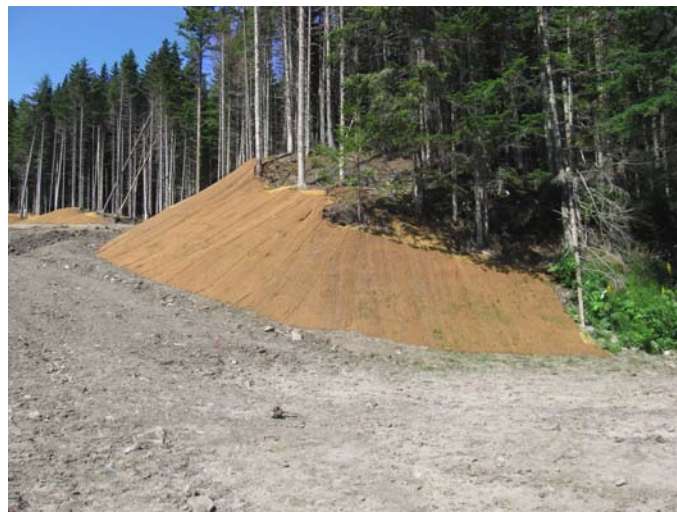
Крепление полосы отвода трубопровода
