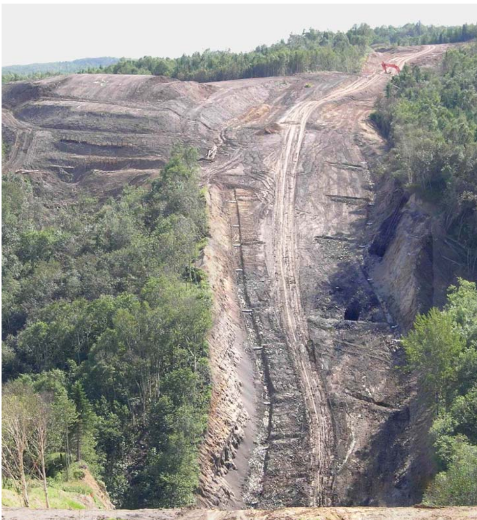
Инженерная защита трубы на трассе трубопровода Сахалин-II сеткой из кокосового волокна
