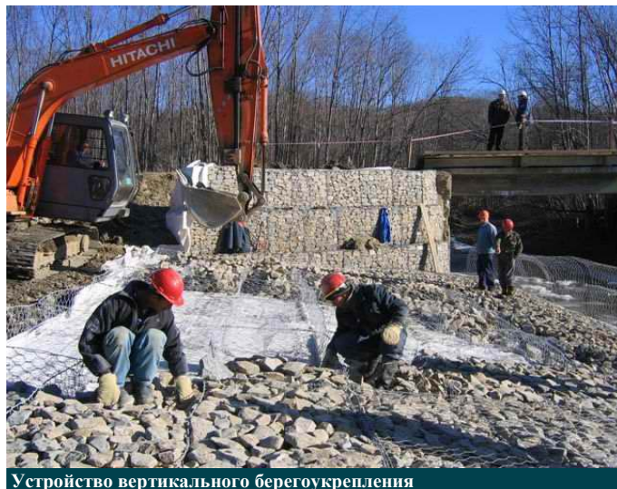
Устройство вертикального берегоукрепления
