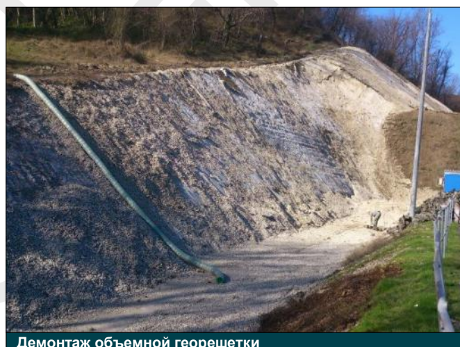
Демонтаж объемной георешетки
