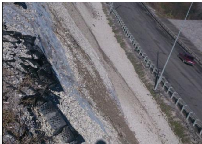
Состояние откоса до начала строительства
