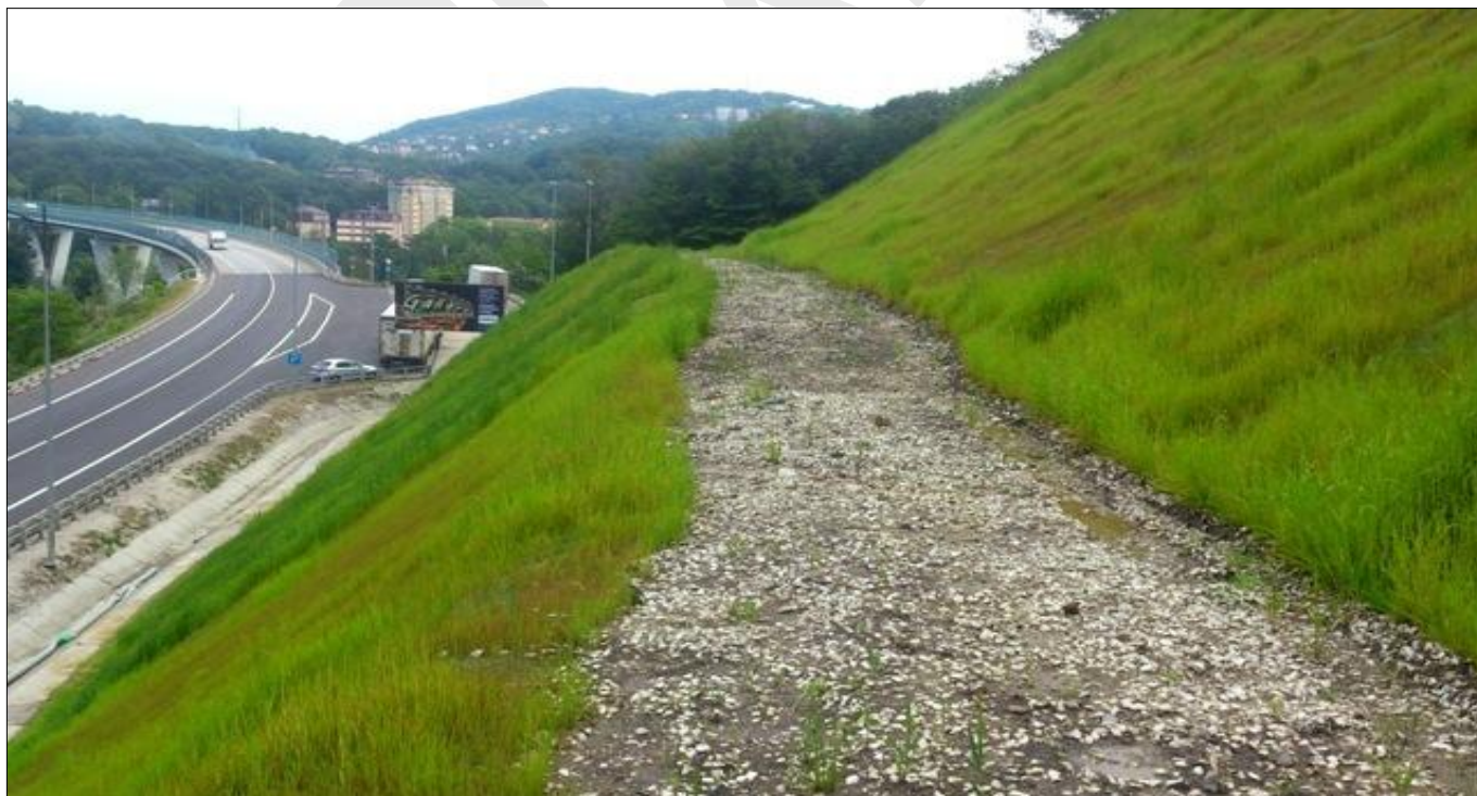
Быстрое озеленение откоса благодаря укладке геомата МакМат™ R 6822 GN
