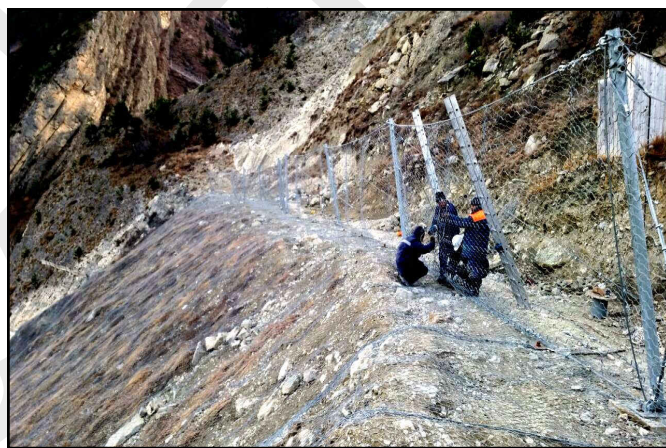
Закрепление улавливающей панели (финальная стадия)
