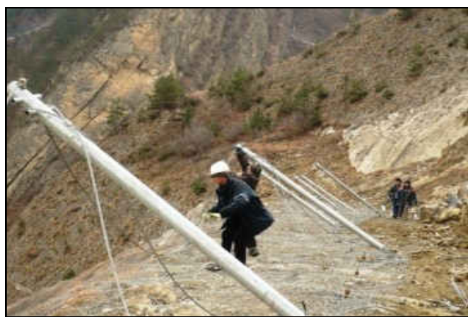
Процесс установки барьера RMC 100A
