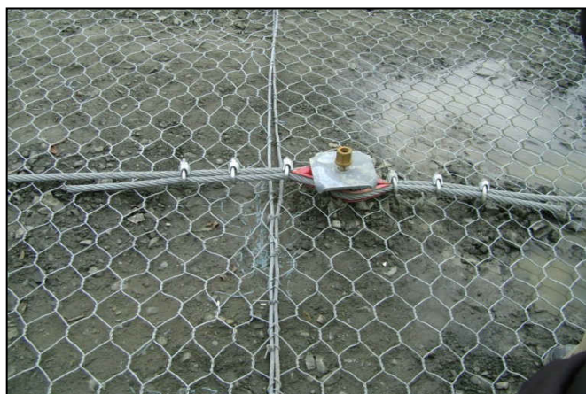
Анкерное крепление системы Стилгрид HR 150
