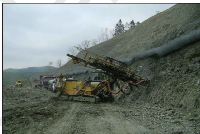
Процесс анкеровки с помощью бурильной техники
