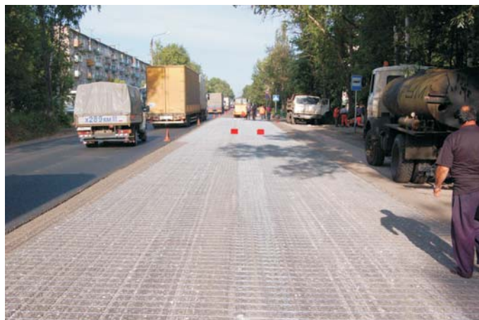
Основание после укладки и анкеровки
