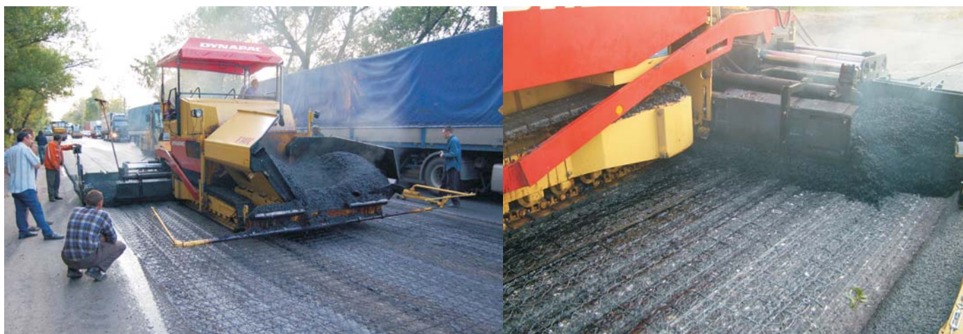
В процессе укладки асфальтобетонного покрытия
