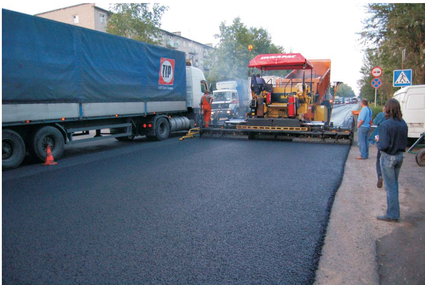
Уложенное асфальтобетонное покрытие
