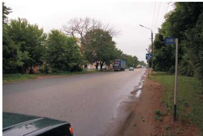
До начала ремонтных работ
