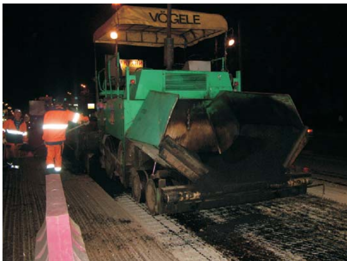
Укладка асфальтобетонного покрытия с использованием колёсного асфальтоукладчика (в ночное время)
