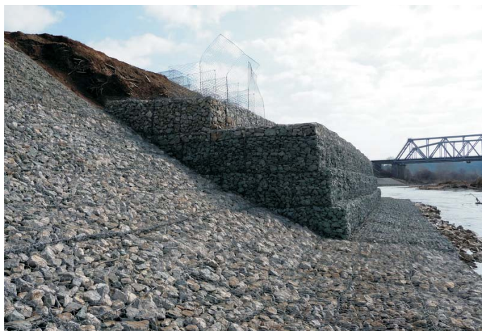
В процессе строительства
