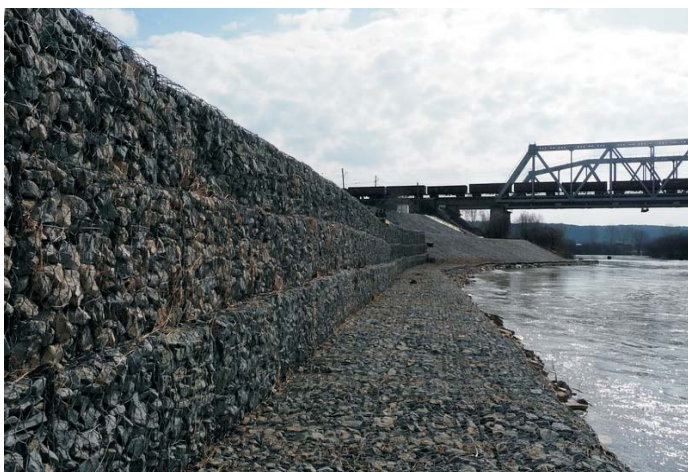
В процессе строительства
