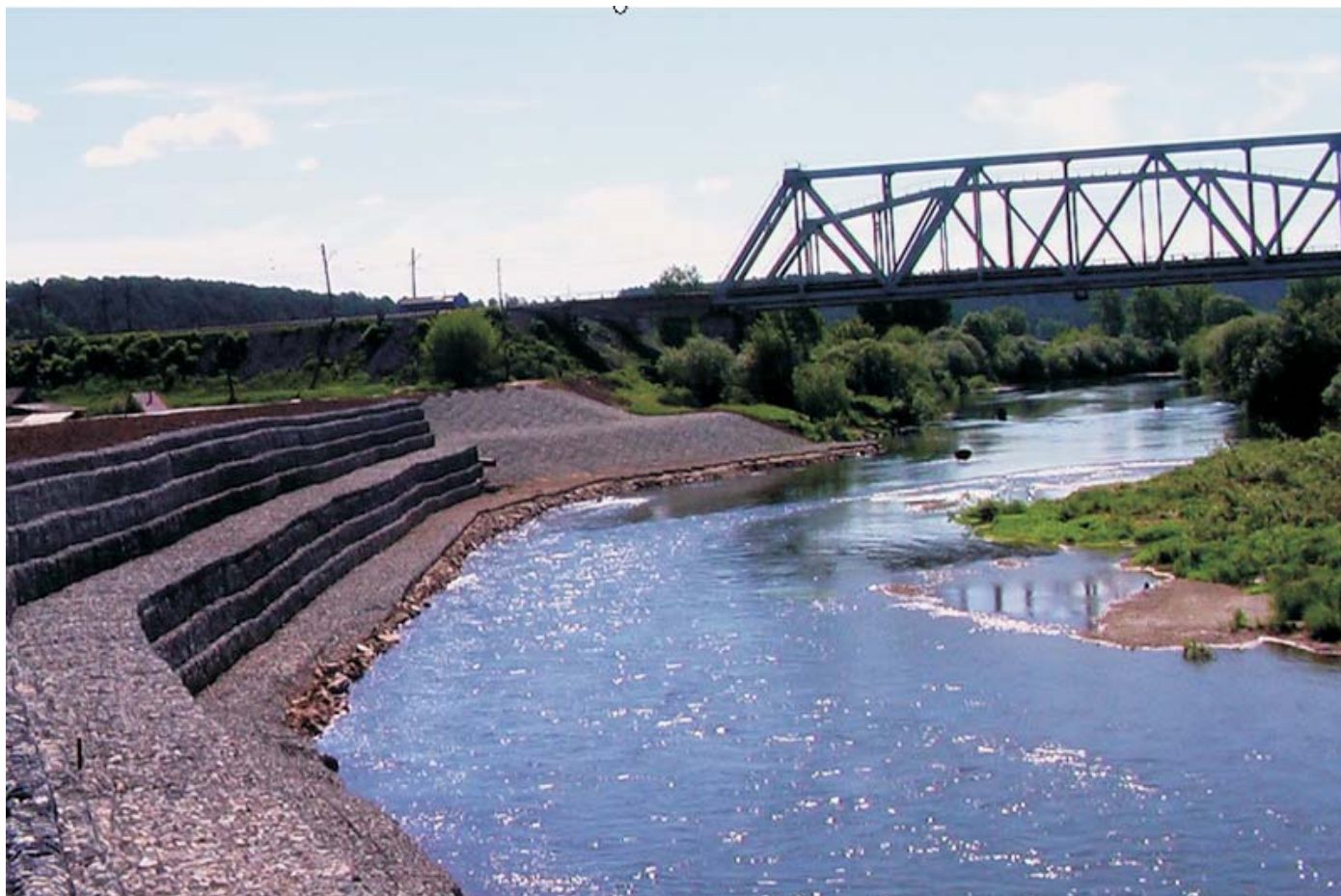
По окончании строительства
