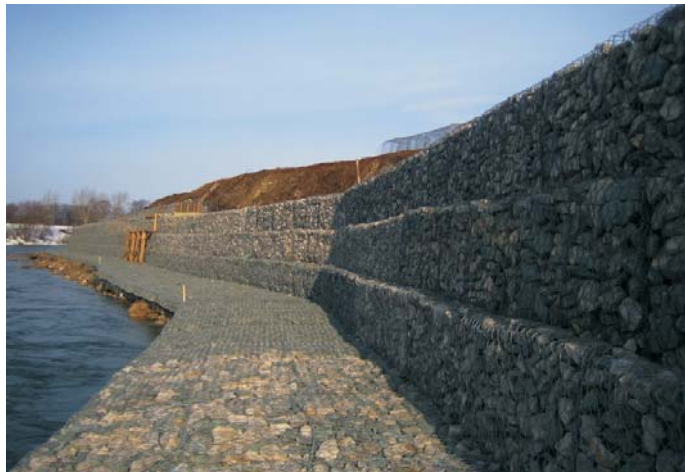
В процессе строительства
