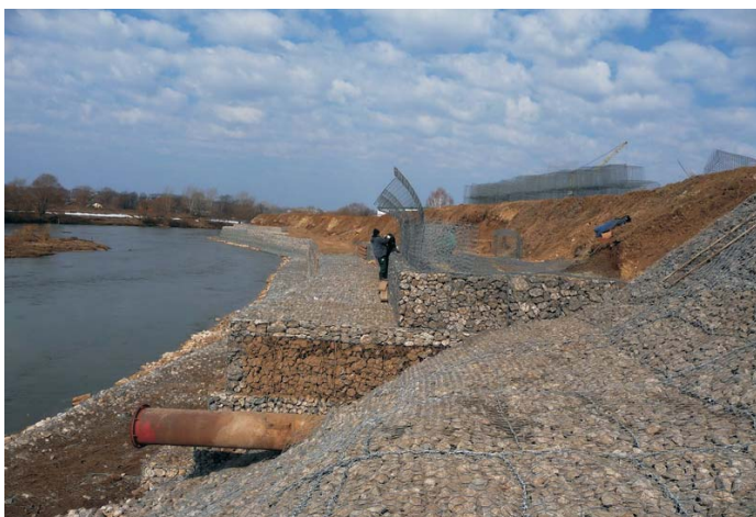
В процессе строительства
