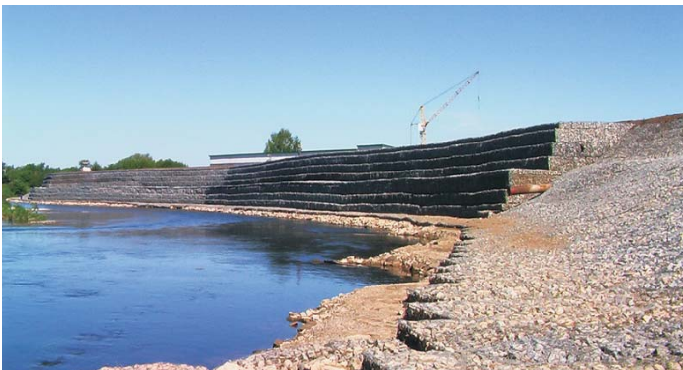
По окончании строительства
