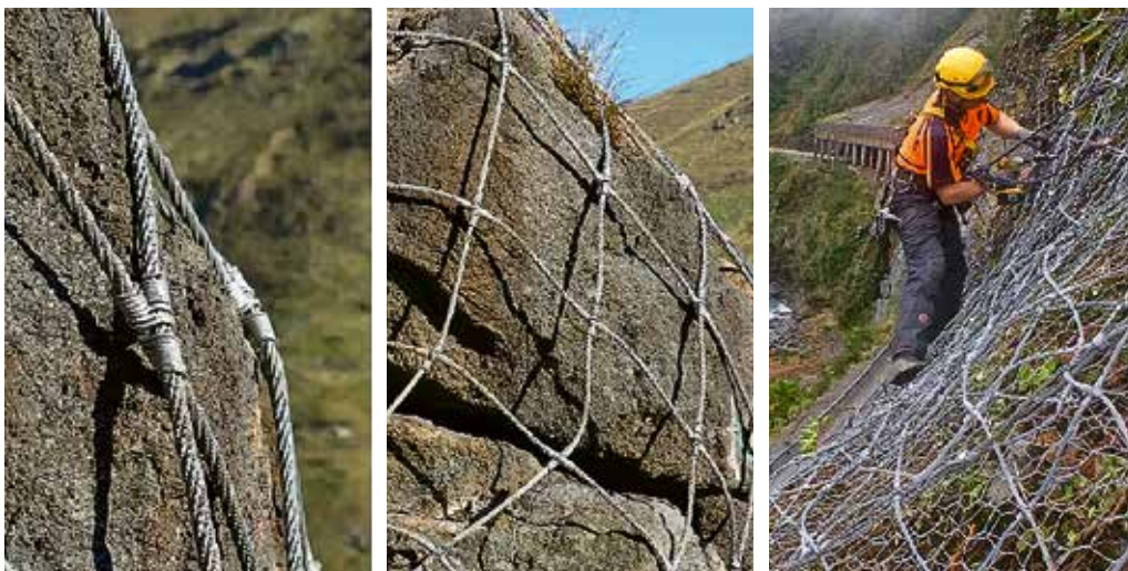
Рис. 9. Применение HEA-панелей на сильнотрещиноватых склонах
