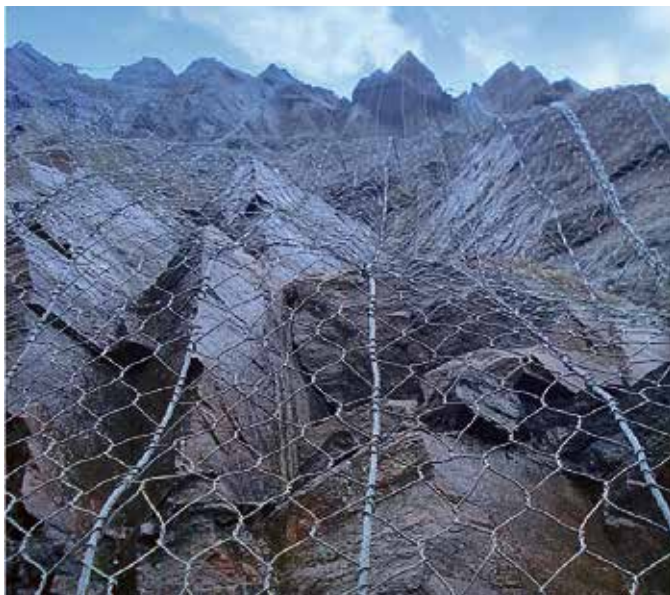
Рис. 3. Простая драпировка склонов
