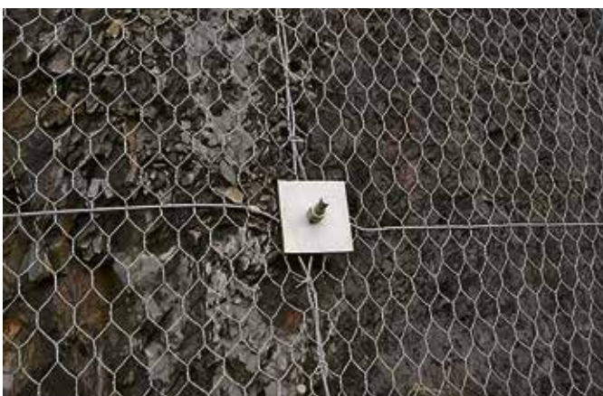
Рис. 8. Анкерное крепление в месте пересечения продольного и поперечного каната Стильгрида ВО
