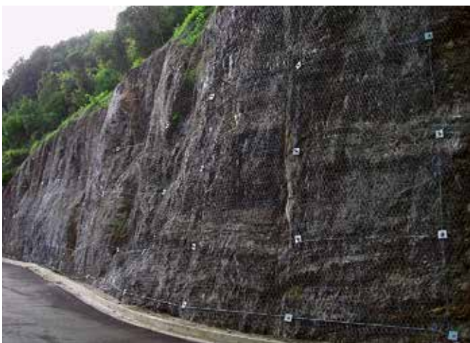
Рис. 4. Драпировка с дополнительным армированием
