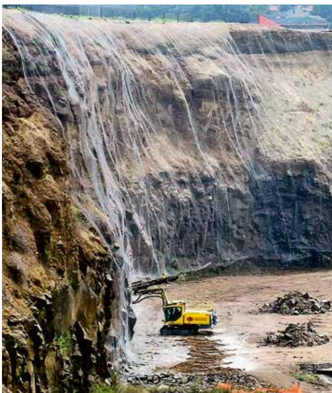
Рис. 1. Драпировка Stilgrid HR на бортах золоторудного карьера, компания Barrick Ltd
