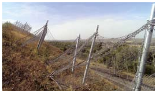
Рис. 4. Снегоудерживающие барьеры OM-СУБ (STR-OM) вдоль Южно-Уральской железной дороги (Оренбургская область)
