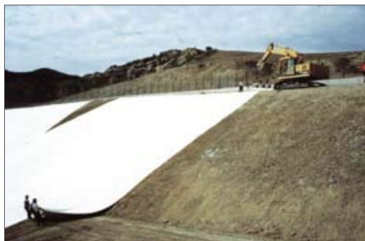
Рис. 3. Устройство откосного дренажа
