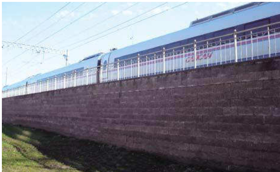
Типовой поперечный вид подпорной стенки с использованием блоков системы «Макволл»
