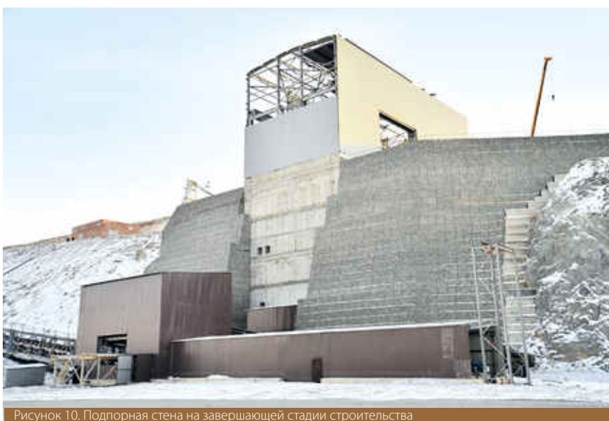
Рисунок 10. Подпорная стена на завершающей стадии строительства
