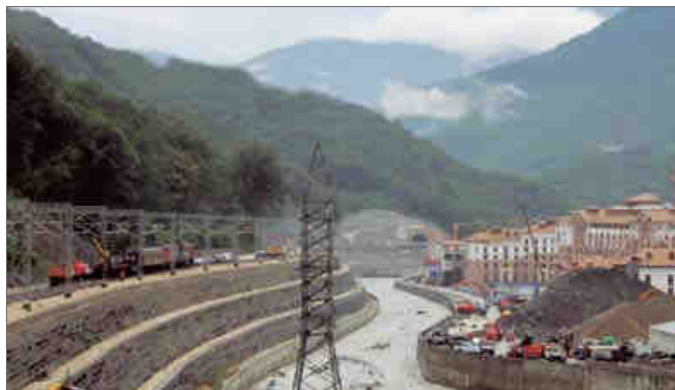
Строительство совмещенной дороги Адлер — горноклиматический курорт «Альпика-Сервис»
