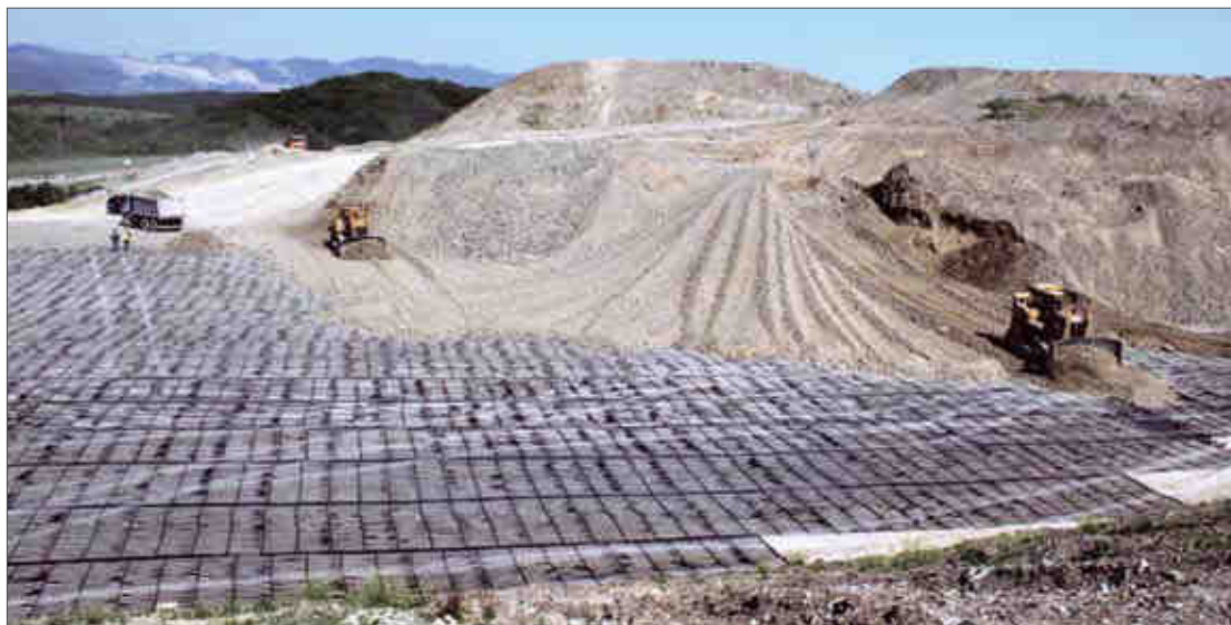
Строительство резервуарного парка Каспийского трубопроводного консорциума
