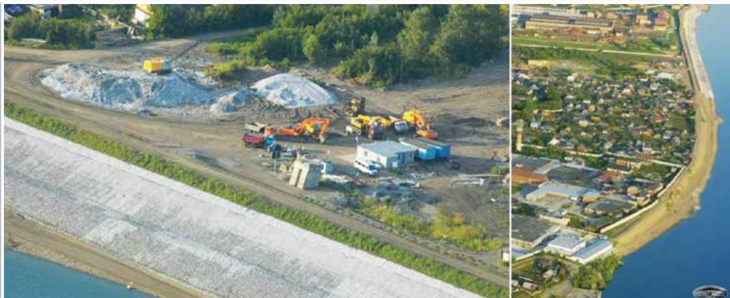
Рис. 5. Внешний вид дамбы в процессе строительства укрепления откосов матрацами Рено
