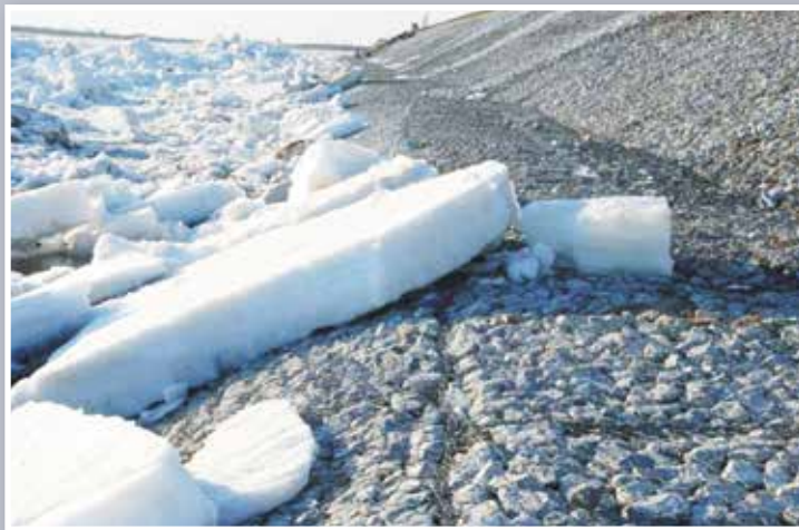
Рис.6. Наполнение льда на откосы дамбы. Локальные Повреждения конструкции крепления
