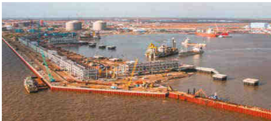
Строительство порта Сабетта
