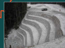
ЗЕЛЕНЬИЙ ТЕРРАМЕШ Сахалинская область, Стабилизация эрозийных врезов в Макаровском районе
