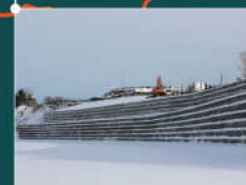
ТЕРРАМЕШ Иркутская область, укрепление берега р. Кетой в Ангарске
