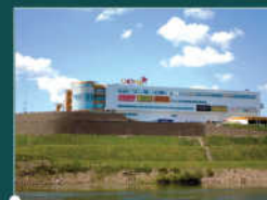
ТЕРРАМЕШ Красноярск, стабилизация эрозийного склона у ТЭЦ «Июнь»
