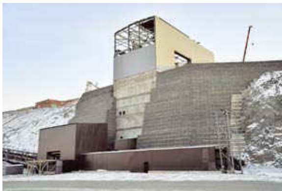
Рис. 3. Подпорная стена на Михеевском ГОКе
