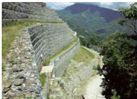
Рис.2. Армогрунтовое сооружение высотой 74 м в Индии
