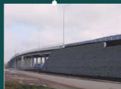
ТЕРРАМЕШ Татарстан, путепровод в г. Зайнск
