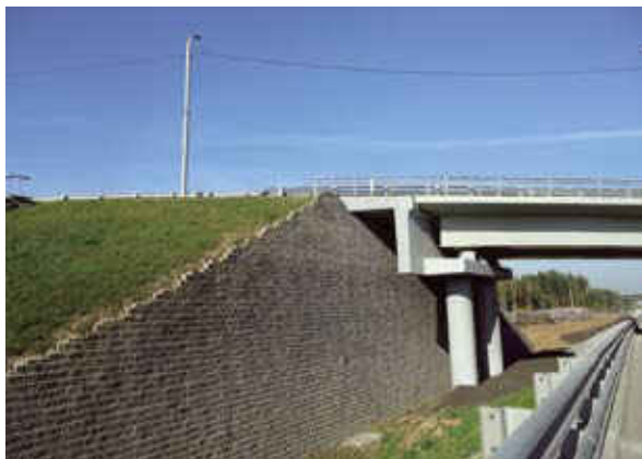
Рис. 5. Укрепление конуса моста с помощью Системы Макволл
