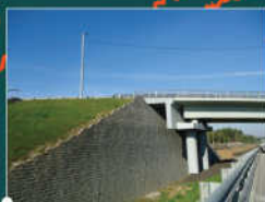
МАКВОЛЛ Московская область, устройство конусов моста в Одинцово
