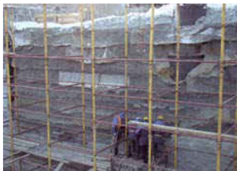
Рис.1. Разобранная армогрунтовая стена во Владивостоке
