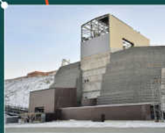
ТЕРРАМЕШ Челябинская область, подпорная стена на Мижеевском ГОКе
