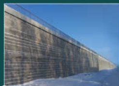
МАКВОЛЛ Московская область, путепровод на 42-ом км А-108 МБК в Михнево
