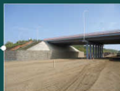
МАКВОЛЛ Башкортостан, путепровод в Демском районе г. Уфы
