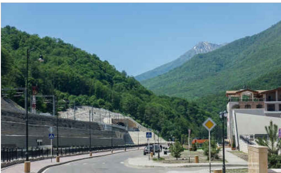
Строительство совмещённой дороги Адлер-Альпика-Сервис
