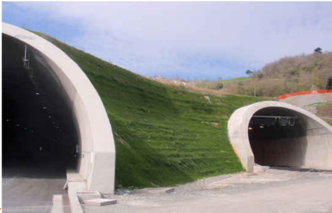
Укрепление порталов тоннеля с помощью Системы Зеленый Террамеш
