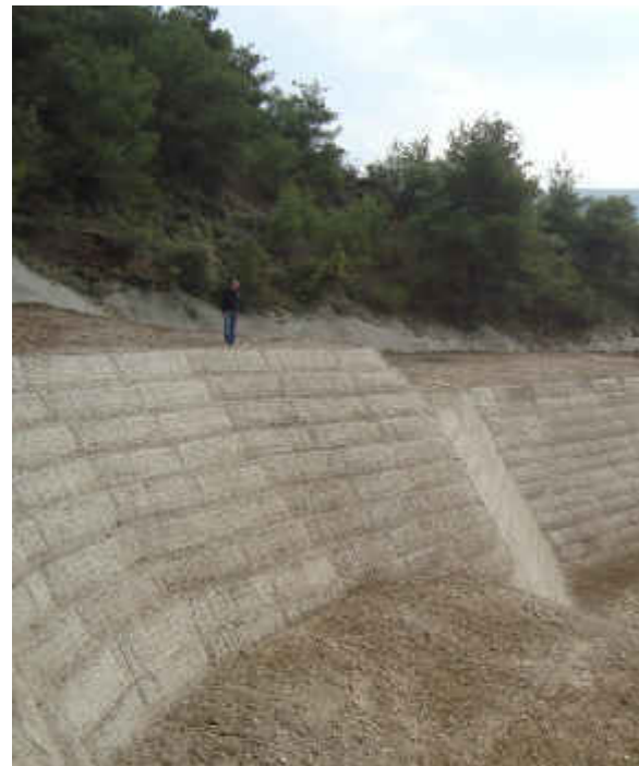
Строительство подпорной стенки с самоозеленяющейся гранью в Шида Картли, Грузия
