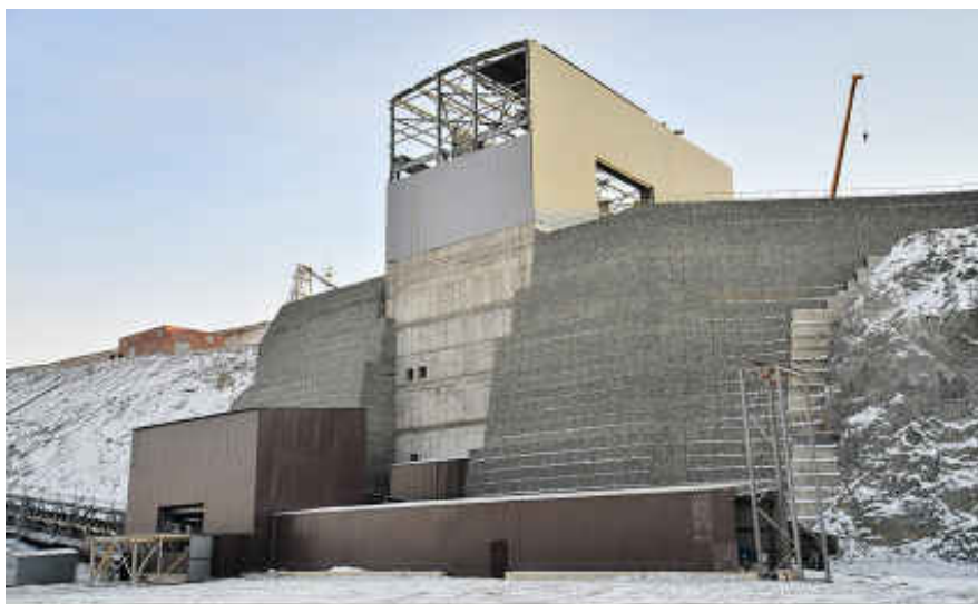
Подпорная стенка дробильного комплекса ГОКа «Михеевский»
