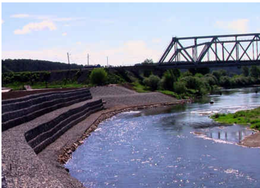
Укрепление защитной дамбы с помощью Системы Террамеш
