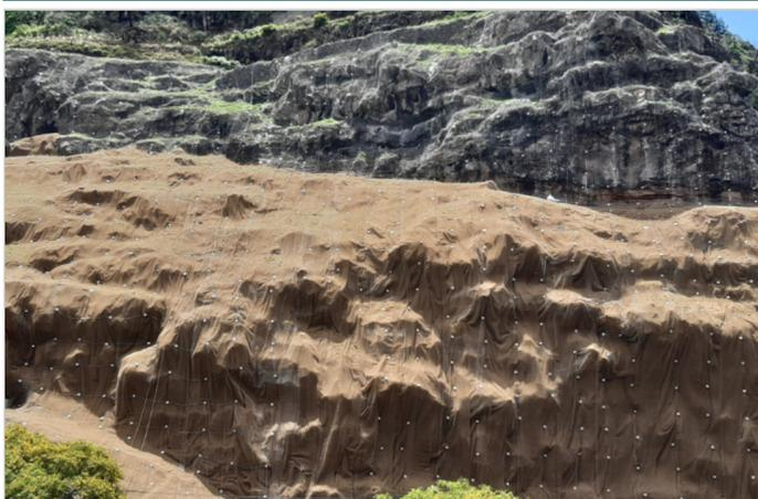
Estabilização com Malha de DT 8x10-16, cabos diâm. 16mm e geomalha MacMat 19.1
