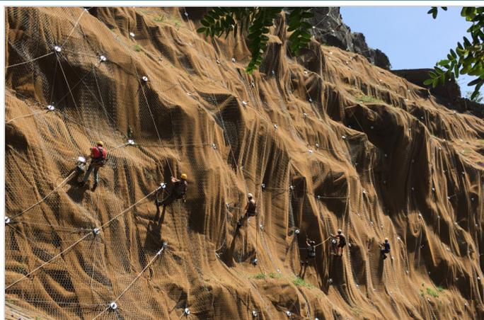
Detalhe da instalação Macmat 19.1, Malha DT 8x10-16 e dos cabos diâm. 16 mm
