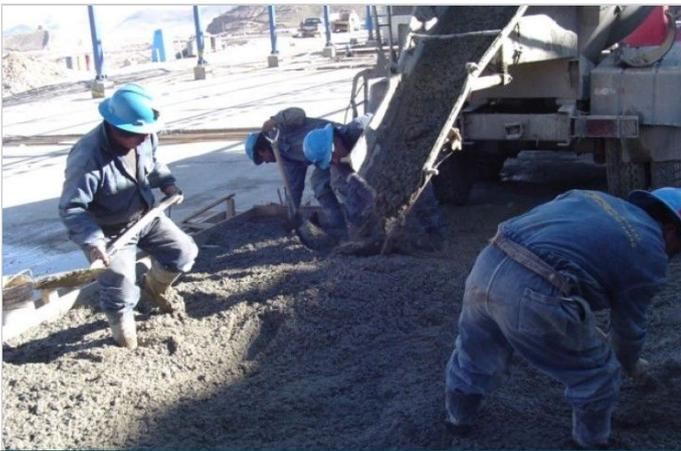
Vaciado de concreto con fibras
