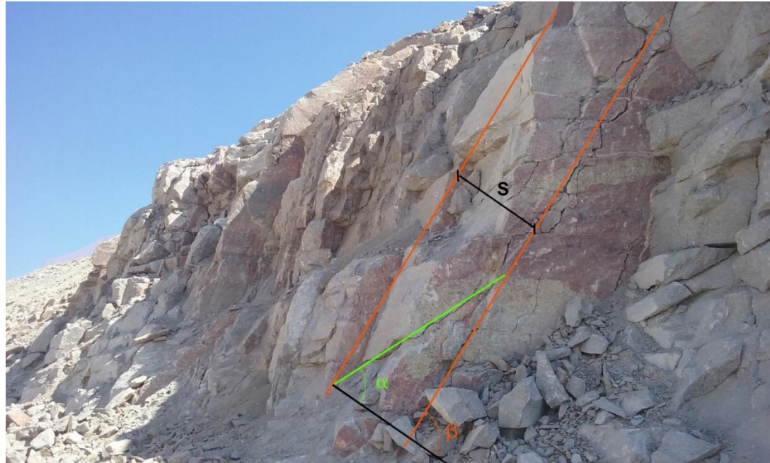
Talud en Roca
