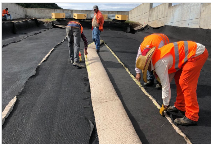
Durante la Obra
