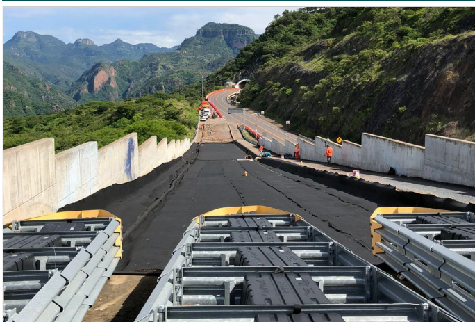
Durante la Obra
