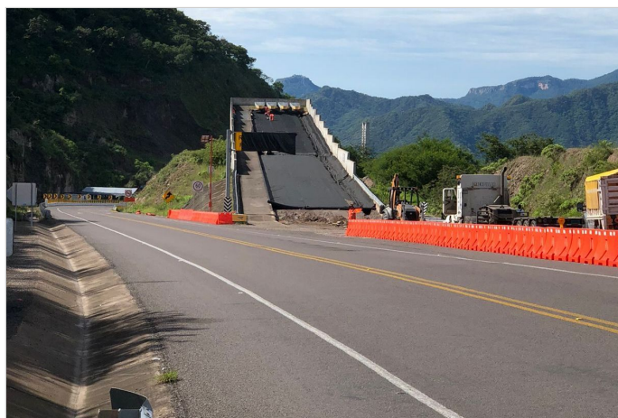
Durante la Obra
