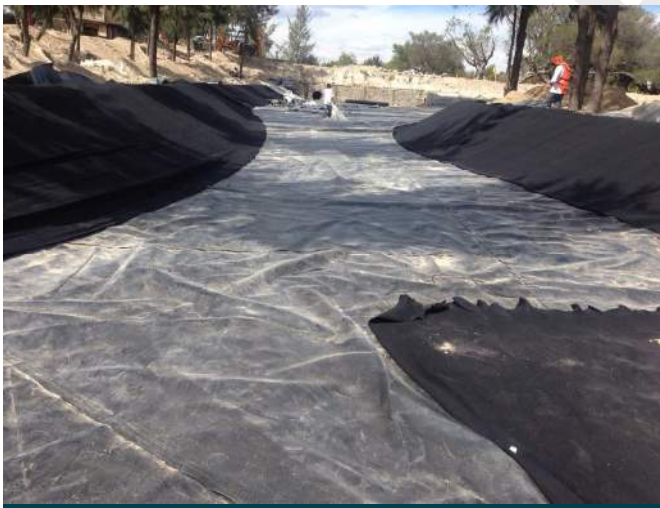
Fig. 5: Instalación geotextil
