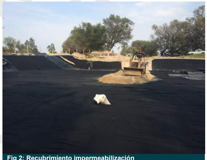
Fig 2: Recubrimiento impermeabilización
