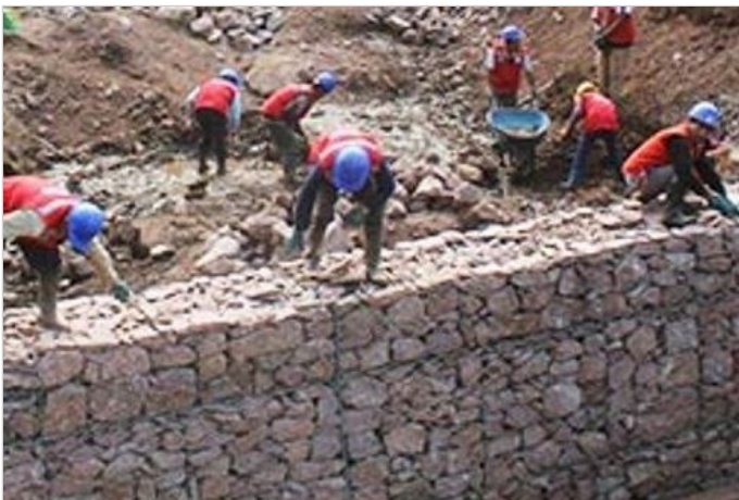
Durante la Obra
