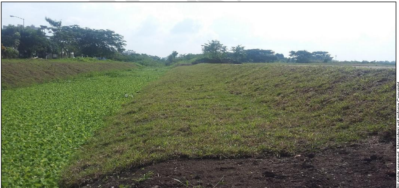
Fig 9. Protección de control de erosión en márgenes de canales con MacMat® en Villahermosa
