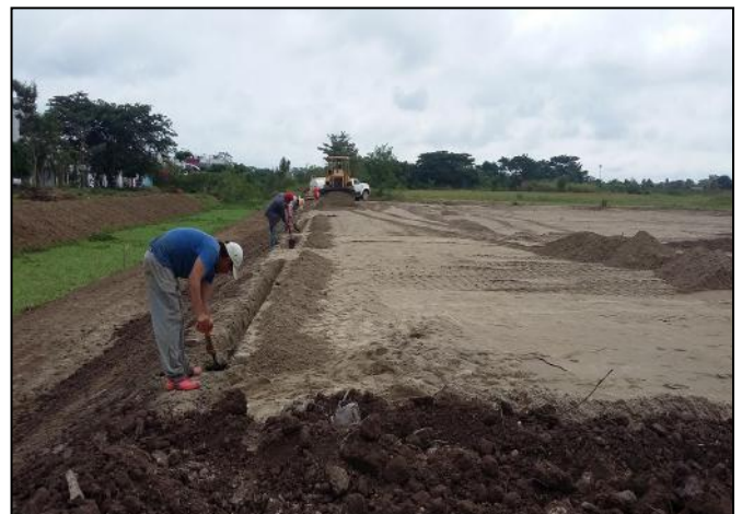
Fig 4. Instalación de MacMat®
