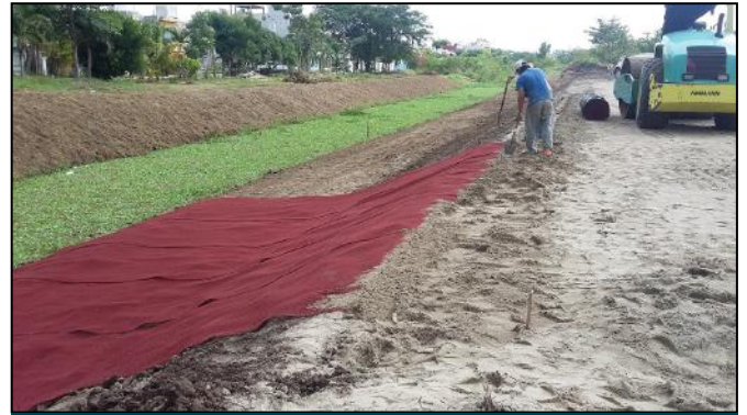
Fig 6. Instalación de material
