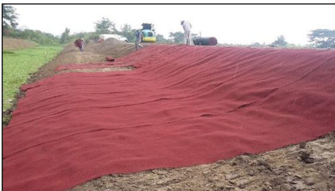
Fig 7. MacMat® colocado
