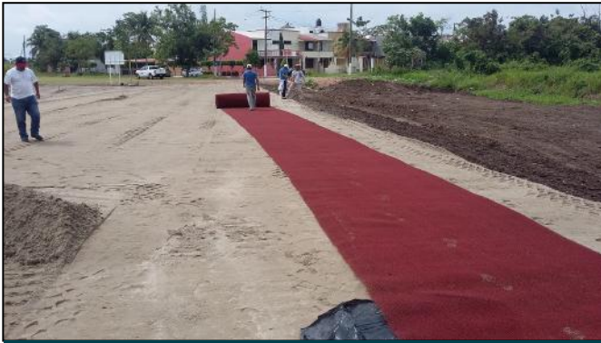
Fig 5. Acomodo en sitio de material
