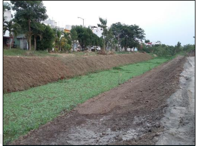
Fig 2. Sitio de Obra
