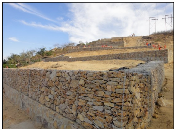
Fig 2. Después de la Obra
