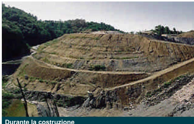
Durante la costruzione
