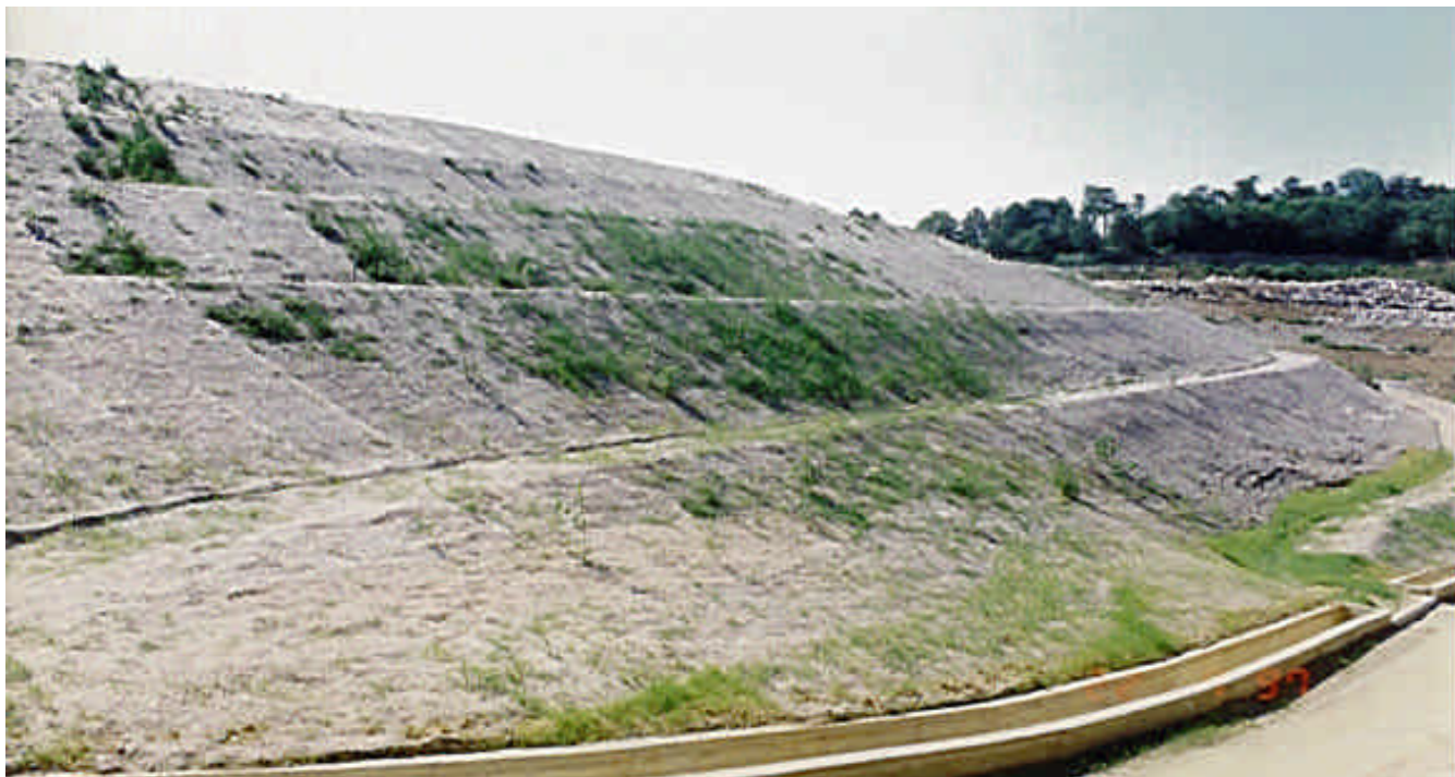
Dopo la costruzione
