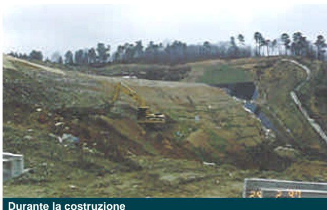
Durante la costruzione
