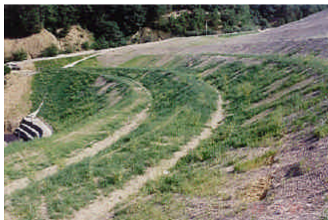
Dopo la costruzione
