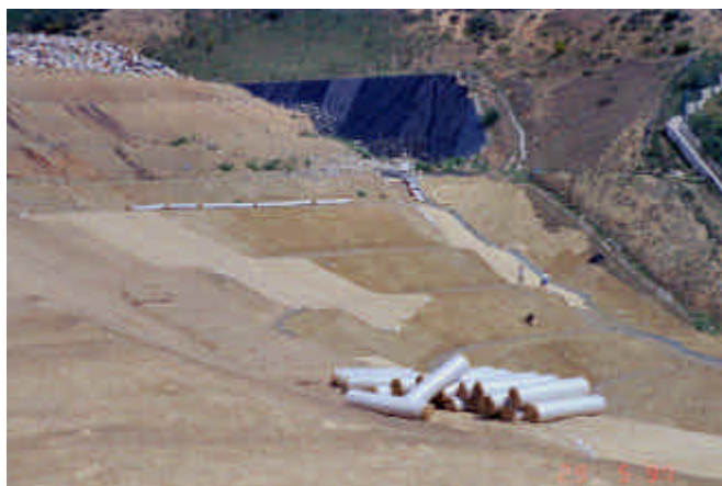
Durante della costruzione
