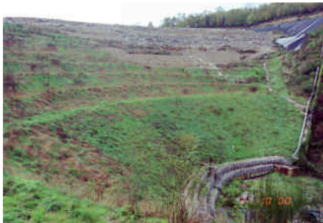
Dopo la costruzione
