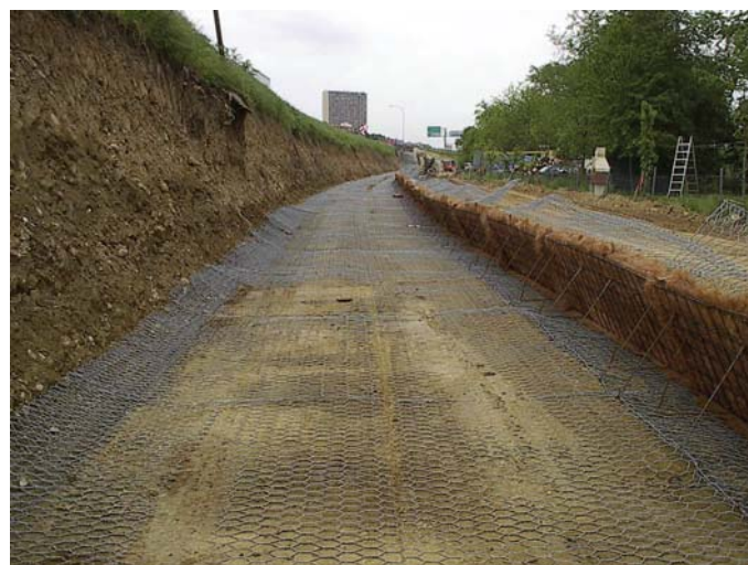
Durante la costruzione
