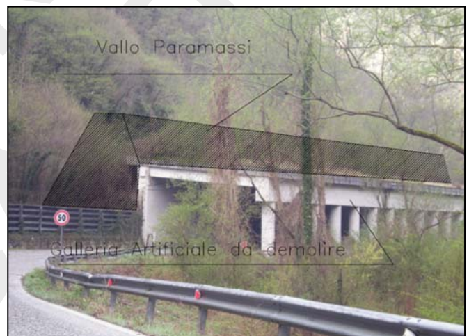
Vista della galleria artificiale demolita e geometria del rilevato paramassi realizzato (fonte: elaborati del progetto esecutivo di Anas)
