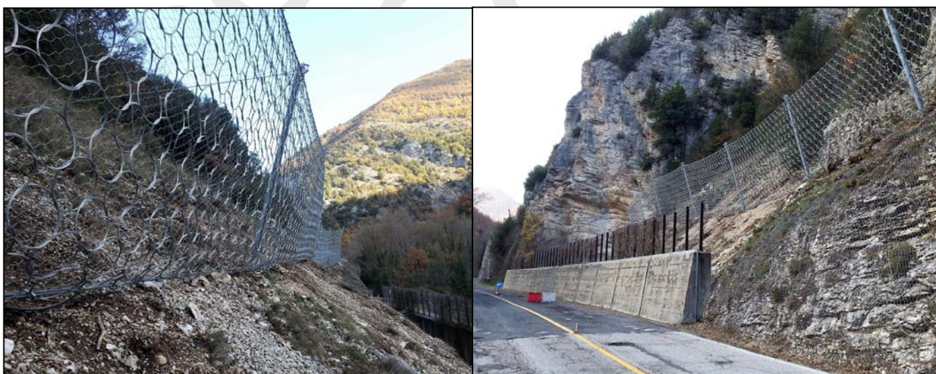
Dettaglio e vista delle barriere paramassi installate
