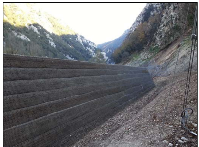
Rilevato paramassi visto da monte
