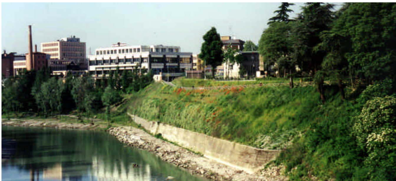
Dopo la costruzione
