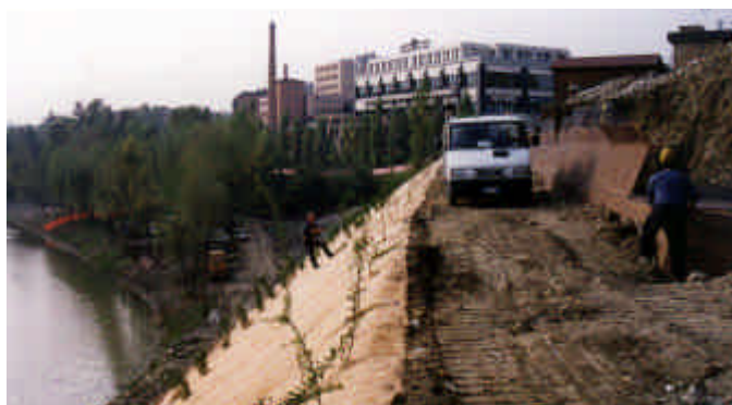
Durante la costruzione
