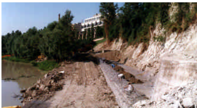
Durante la costruzione
