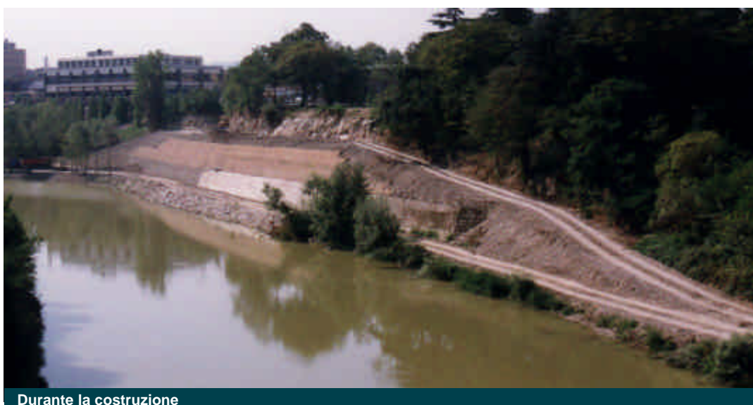
Durante la costruzione
