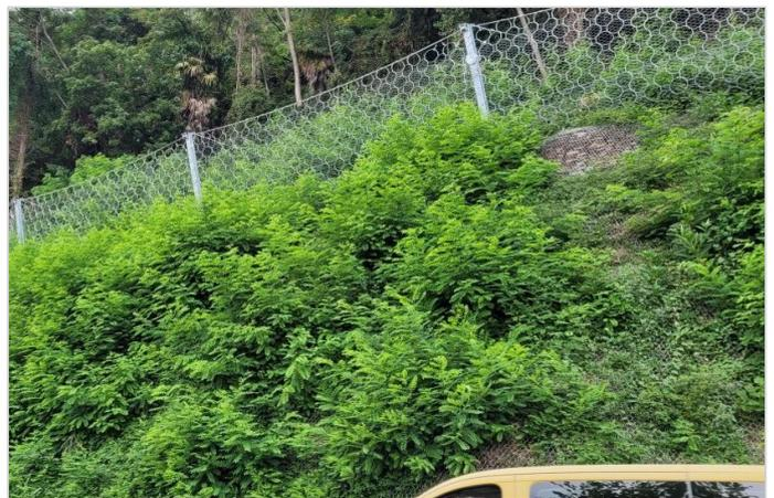
Drapery con DTNET 6x8 d.2,7mm al di sotto delle barriere paramassi
