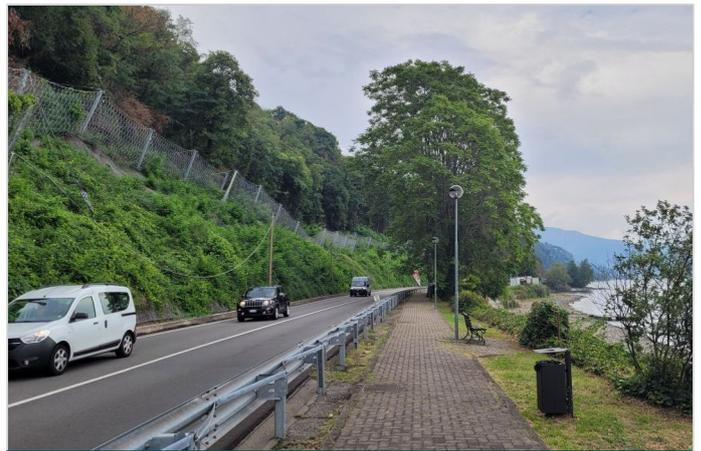
Protezione della SS34 con le barriere RB2000 e RB1500 integrate con Hellomac
