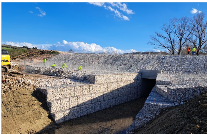
Esecuzione dei lavori - ripristino dei gabbioni a valle dello sbarramento
