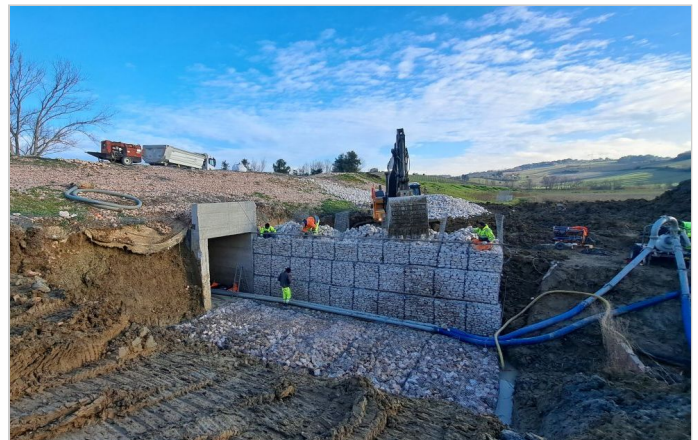
Esecuzione dei lavori - Ripristino del Fosso a monte dello sbarramento
