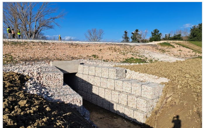
Protezione all'entrata del culvert completata
