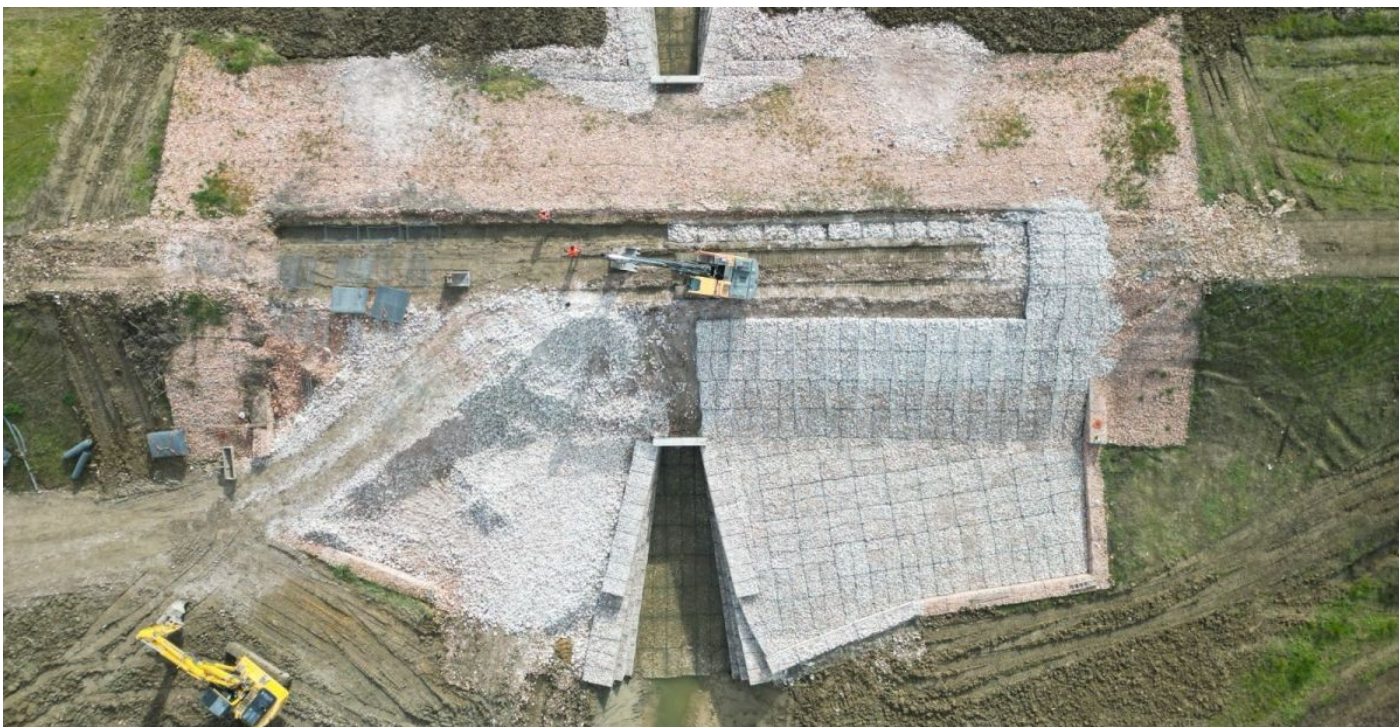
Esecuzione dei lavori vista dall'alto
