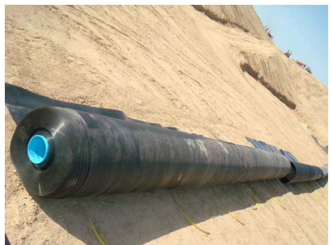
Photo2. HDPE Geo-membrane rolls
