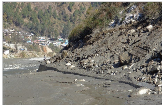
Photo 1: Eroded afflux bund
