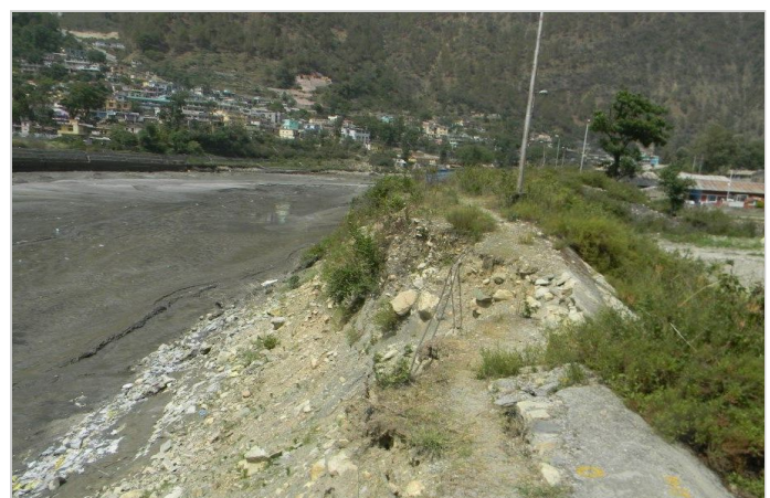
Photo 2: Eroded afflux bund
