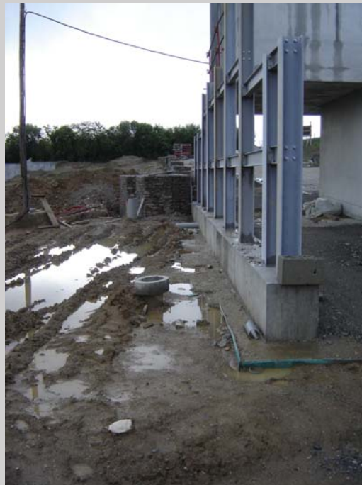
Pendant les travaux
