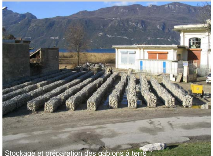
Stockage et préparation des gabions à terre
