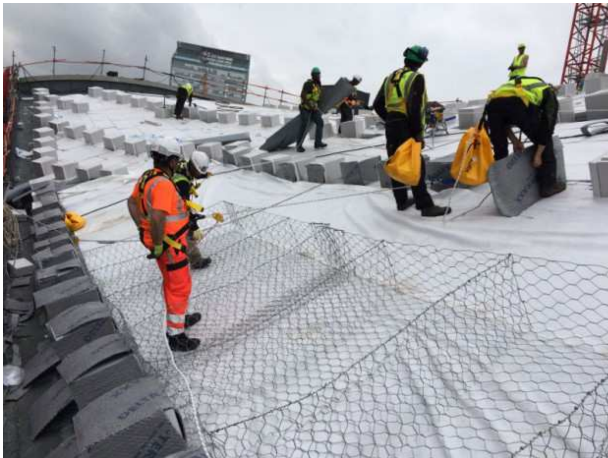
Chantier de la Cité de la musique, sur l'île Seguin à Boulogne-Billancourt. © France Maccaferri
