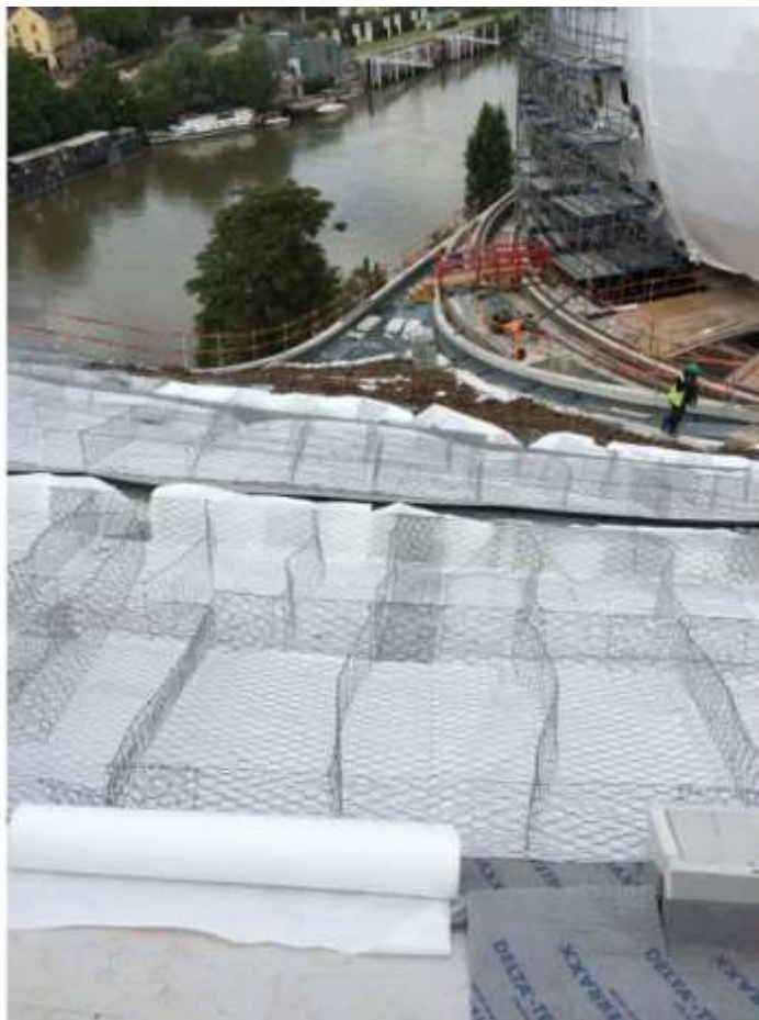
Chantier de la Cité de la musique, sur l'île Seguin à Boulogne-Billancourt. © France Maccaferri
