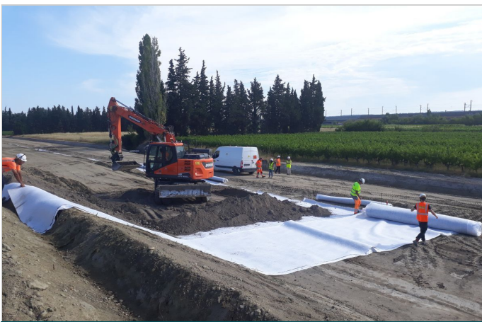
Mise en oeuvre MacDrain W1081
