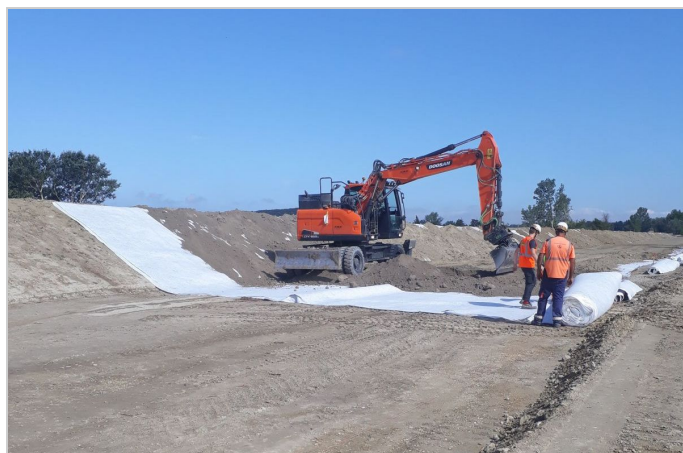
Mise en œuvre MacDrain W1081
