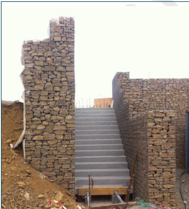
Sol renforcé et mur poid entourant l'escalier
