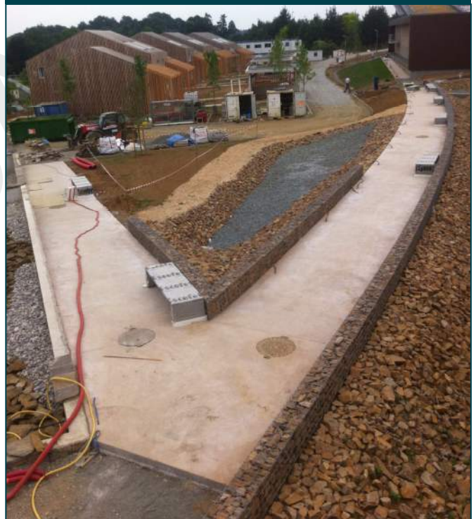
Murets décoratifs au niveau des noues
