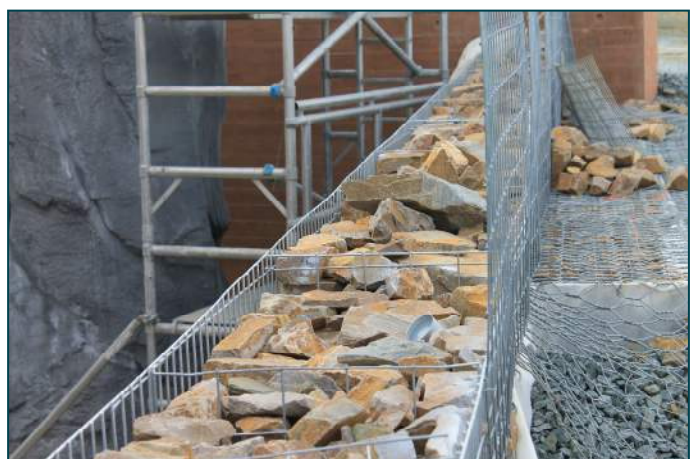
Figure 3 : Gabions électrosoudés avec nappes de renfort
