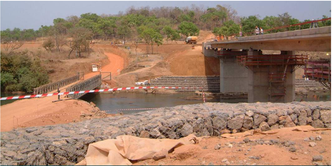
Après les travaux
