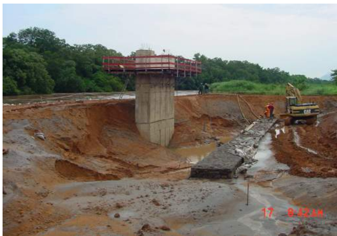
Pendant les travaux
