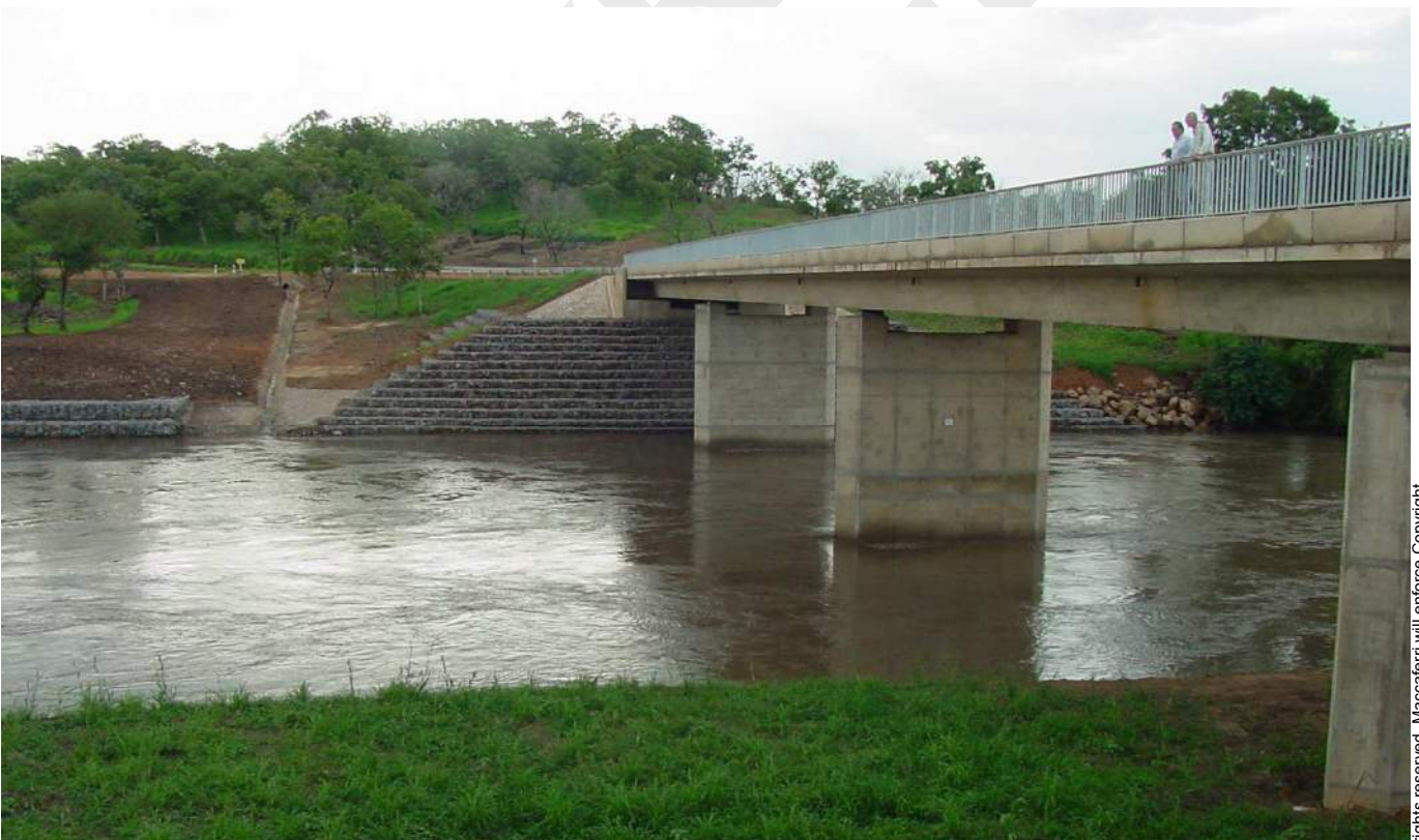
Après les travaux
